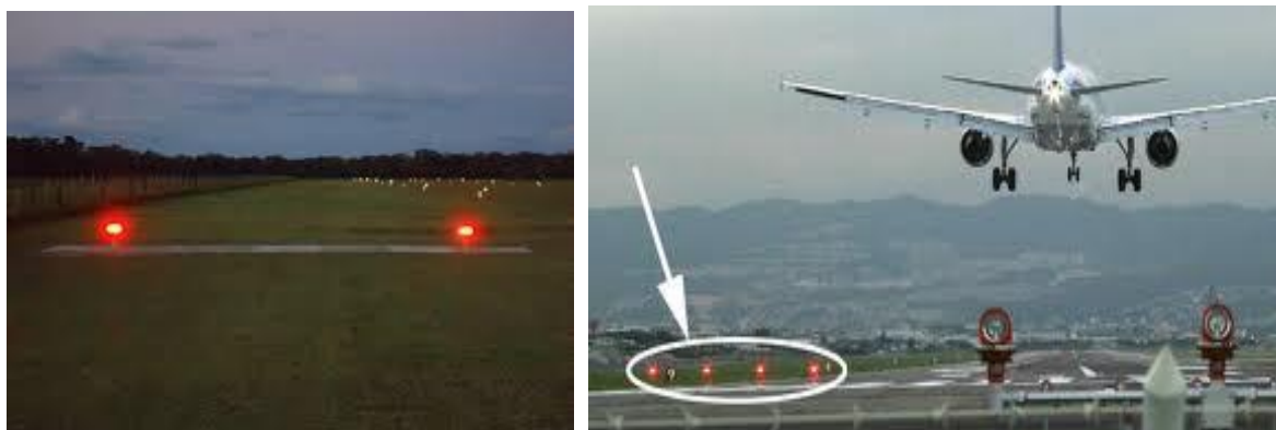
Foto 10 : Exemplo e identificação de PAPI em Pista
