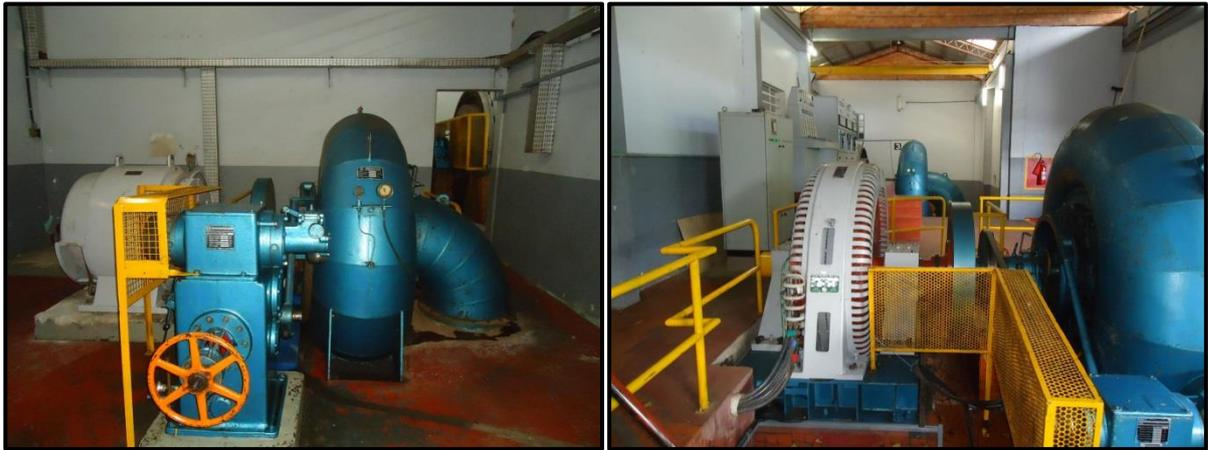
**Figura 11 - Turbinas instaladas na casa de força da CGH Pinho Fleck.**
