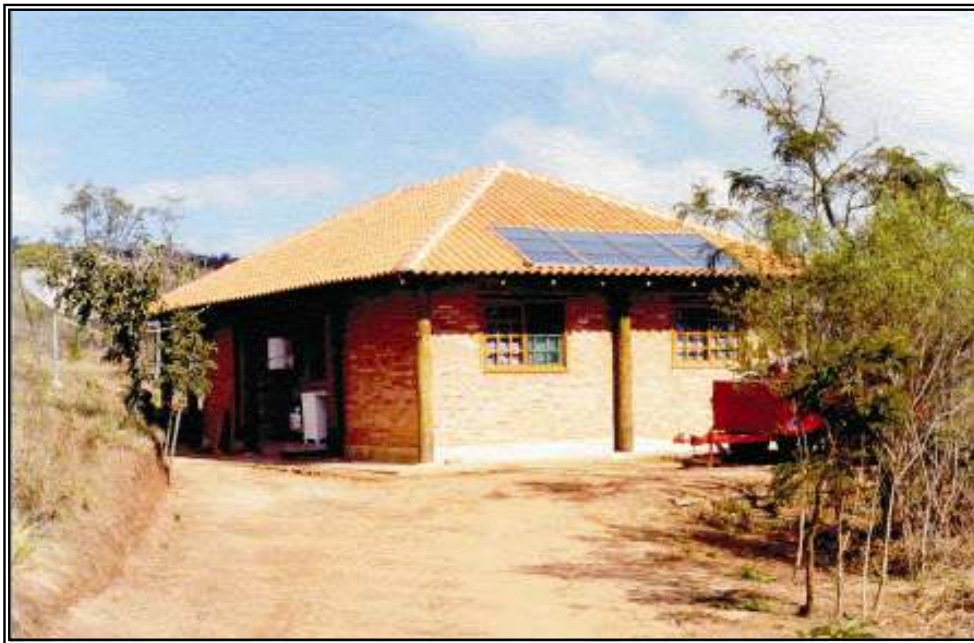
Foto VI.03 - Vista da Casa do Guarda-Parque (fonte: G. Gaertner, 2002)
