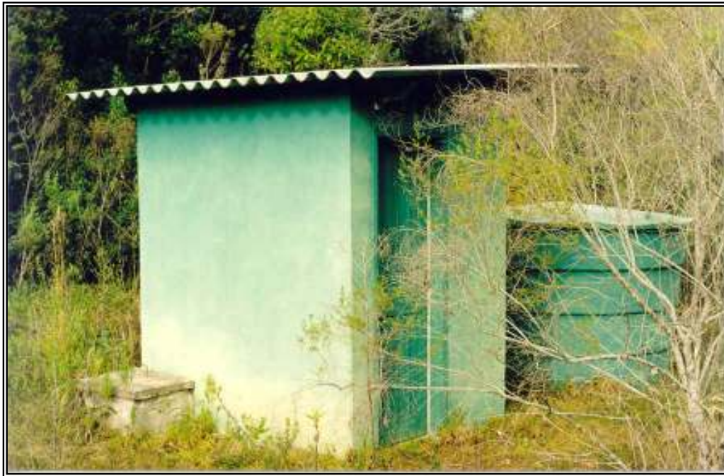
Foto VI.07 - Vista da Casa de Abastecimento de Água (fonte G. Gaertner, 2002)
