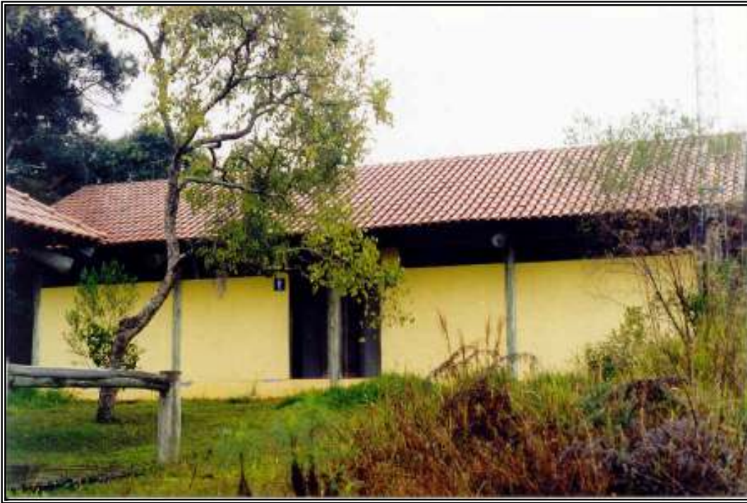
Foto VI.12 - Vista do Banheiro Existente ao Lado do Camping (fonte G. Gaertner, 2002)
