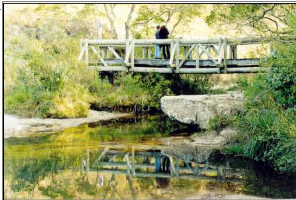
Foto VI.09 - Vista da Ponte de Madeira 2 (fonte G. Gaertner, 2002)
