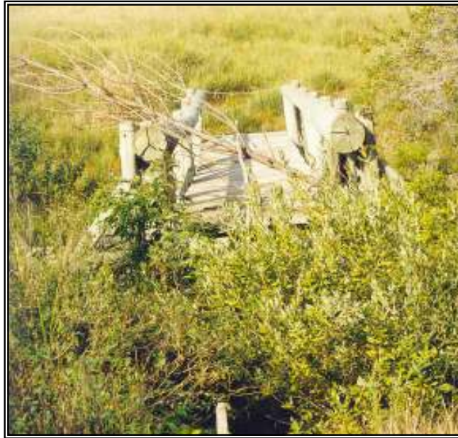
Foto VI.10 - Vista da Ponte de Madeira 2 (fonte G. Gaertner, 2002)
