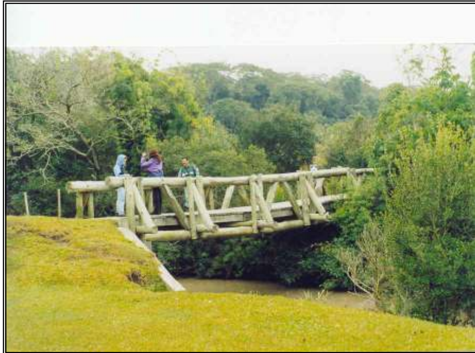
Foto VI.08 - Vista da Ponte de Madeira 1 (fonte G. Gaertner, 2002)
