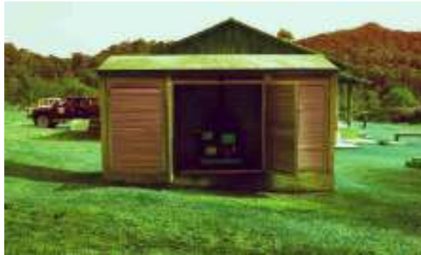
FIGURA 5.6 CASA DO GERADOR À DIESEL
