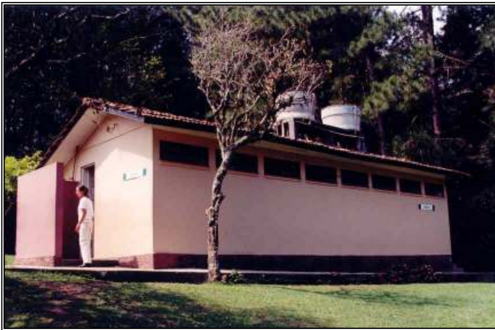
Foto VI.12 - Sanitários e Almojarifados de Ferramentas (fonte: A. Wandembruck, 2002)
