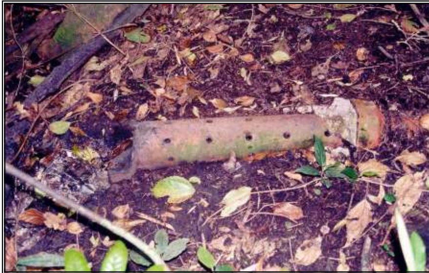
Foto VI.35 - Sistema de Esgoto (fonte A. Wandembruck, 2002)
