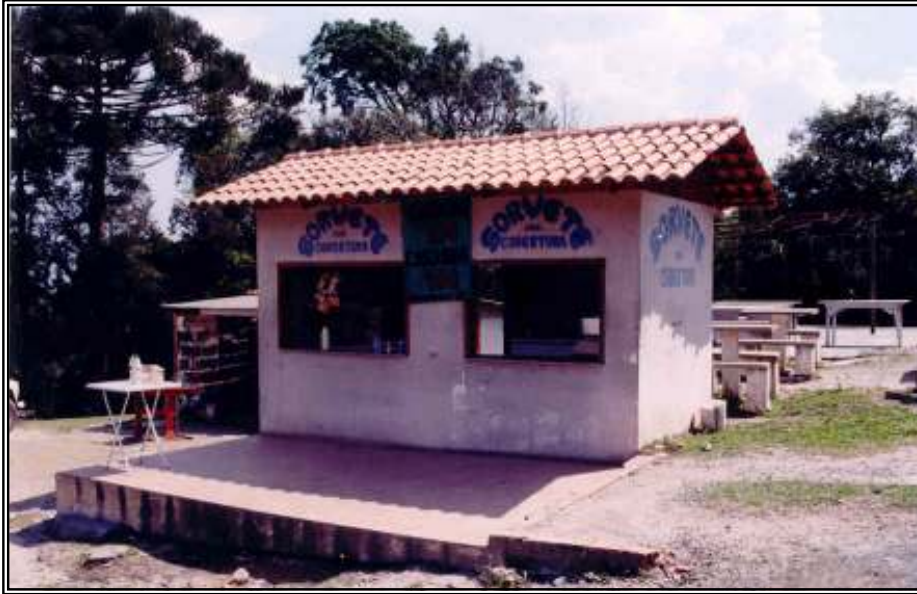
Foto VI.36 - Falta de Padronização da Infra-estrutura (fonte A. Wandembruck, 2002)
