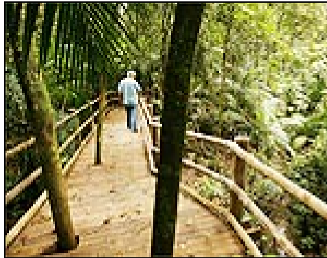
Foto 4.01 - Exemplo de Passarela
