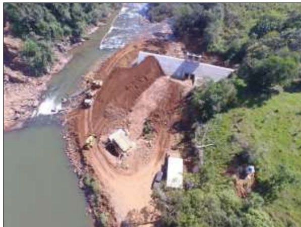
Figura 4.2: Exemplo de desvio, primeira fase. Fonte: Construnível, 2016.
