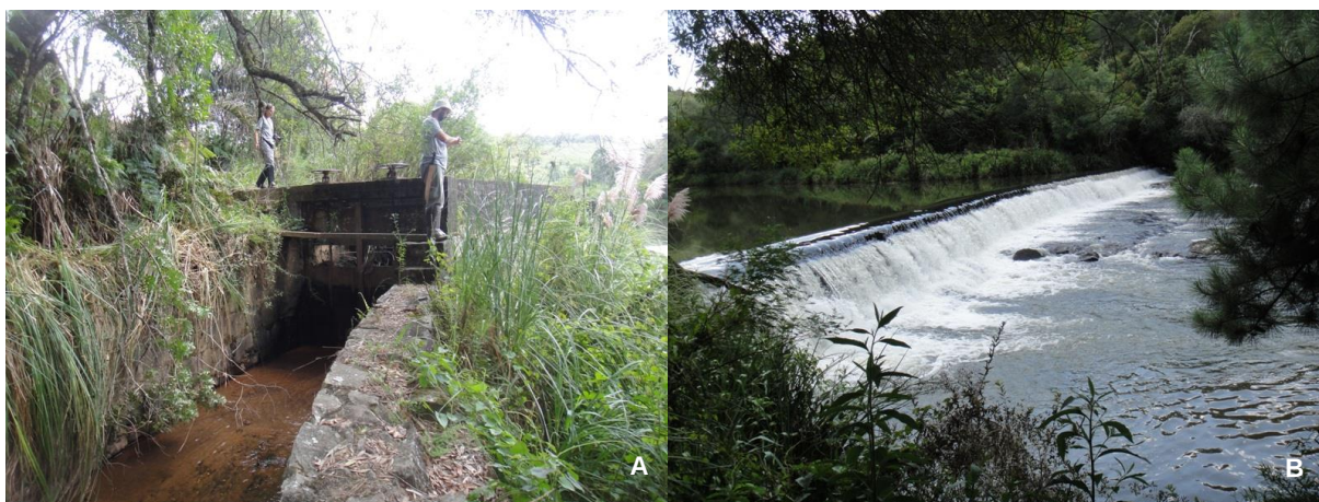
Figura 39: A- Tomada da água da antiga usina existente no rio da Estrela; B- Barramento da antiga usina hidrelétrica no rio da Estrela
