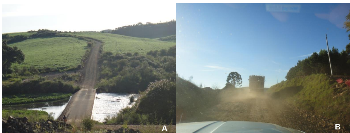
Figura 73: A– Rodovia de acesso e áreas de cultivo de soja na AID B- Suspensão de material particulado
