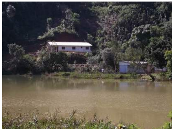
Figura 4-9: Residências localizadas na APP do reservatório da PCH Santa Cruz (margem direita).
