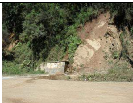
Bica de água, estrada do Saivá.
