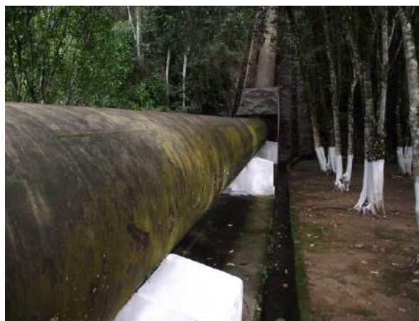
Figura 2-4: Conduto Forçado.
