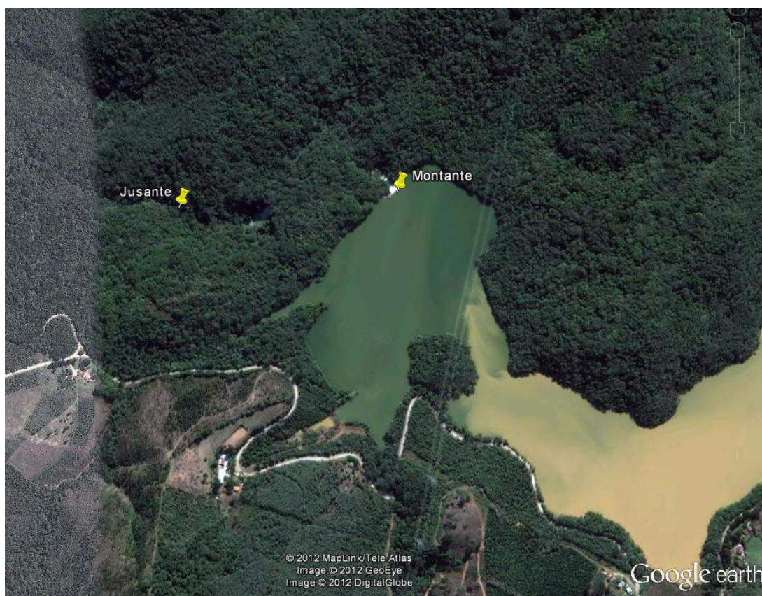
Figura 5-2: Pontos de Monitoramento da Qualidade das Águas
