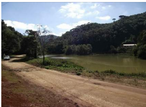
Figura 3-41: Possível ponto de transbordamento do reservatório.
