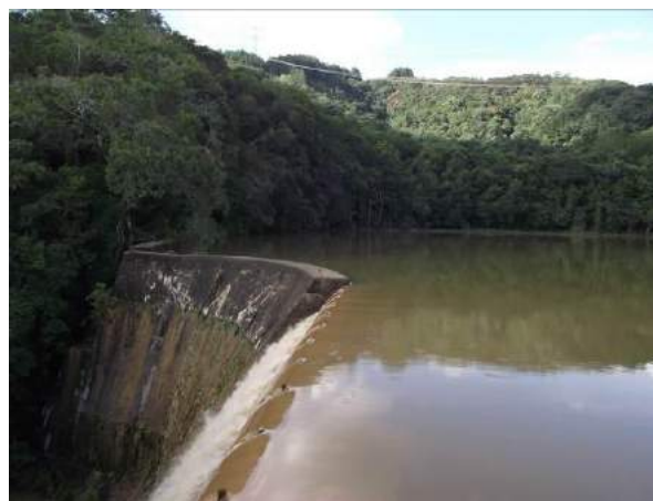
Figura 2-6: Reservatório e vertedouro.
