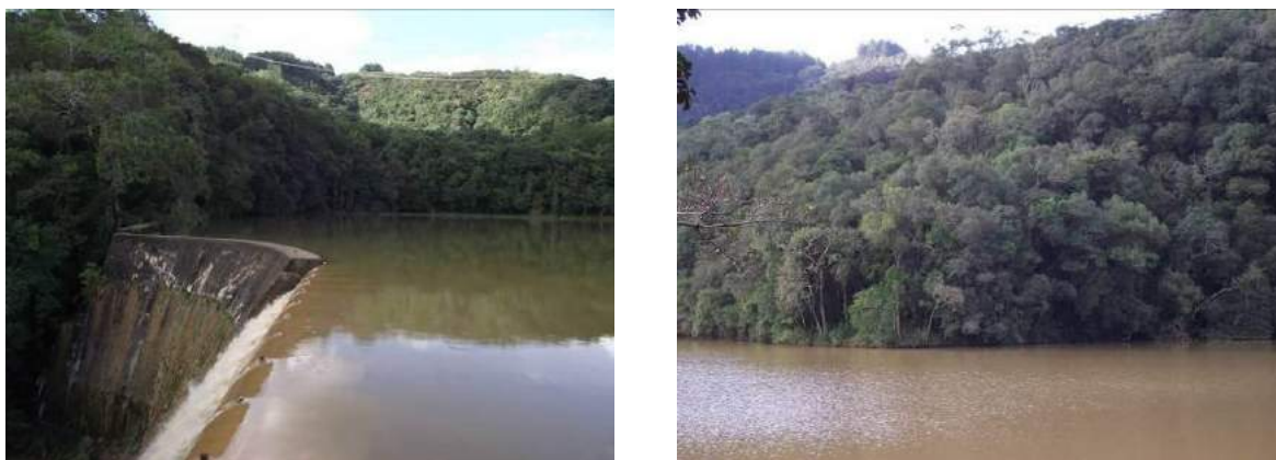
Áreas com vegetação mais estruturada localizadas na margem direita do reservatório.
