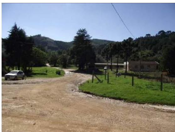
Vila localizada a montante do reservatório da PCH Santa Cruz.
