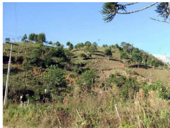
Pasto em área sujeita a escorregamento na margem esquerda do reservatório.
