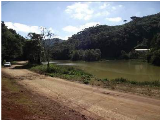
Figura 4-8: Vista da estrada não pavimentada e residências na APP (margem direita).
