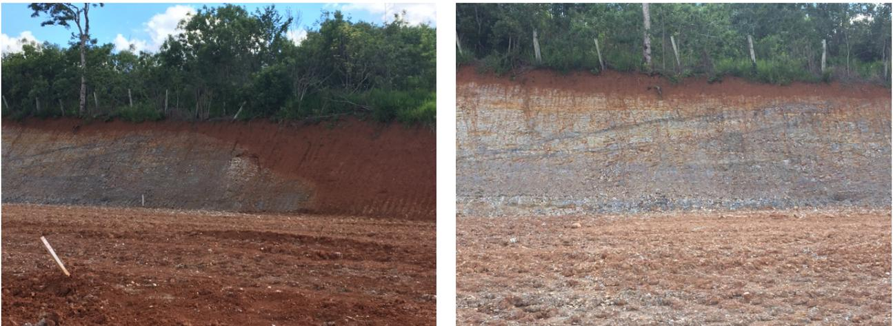
FOTOS 12 E 13 - AFLORAMENTOS DOS FOLHELHOS DA FORMAÇÃO PONTA GROSSA EM CORTES DE BARRANCOS EXISTENTES NA AID E AII
