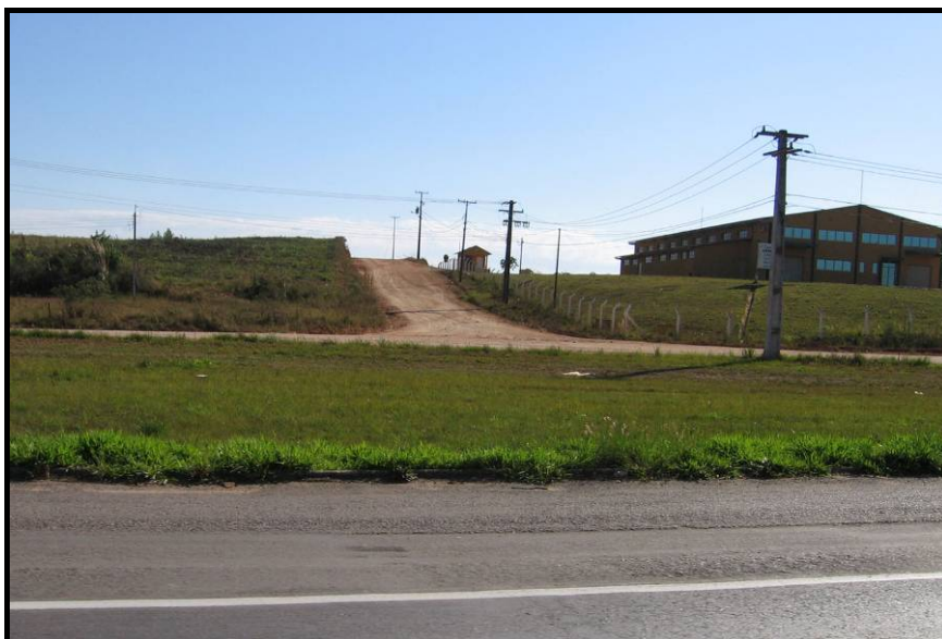
Figura 7.22 - Acesso a área de Mandirituba. Notar pista marginal implantada.
