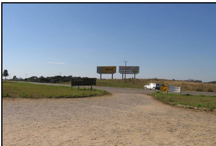
Figura 7.23 - Acesso da área de Mandirituba. Notar pista marginal implantada.
