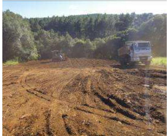
**Figura 36.** Aterro com material retirado da célula. **Fonte:** Cledson Wiezorek
