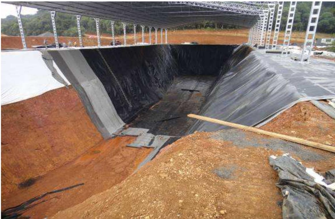
**Figura 41.** Colocação de uma camada de geotextil e uma camada de geomembrana 1,5mm.
