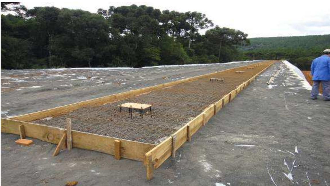
**Figura 38.** Exemplo das sapatas para receber estrutura do telhado. **Fonte:** Cledson Wiezorek
