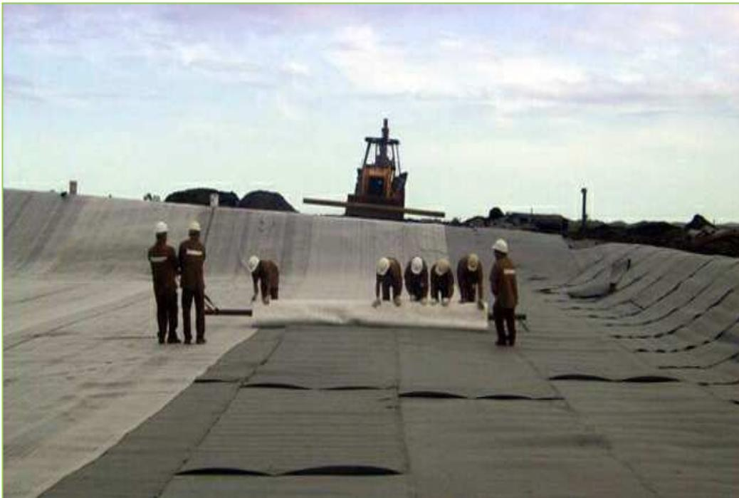
**Figura 44.** Exemplo de manta utilizada na construção do aterro. **Fonte:** <http://vogelsangerempresendimentos.com.br>
