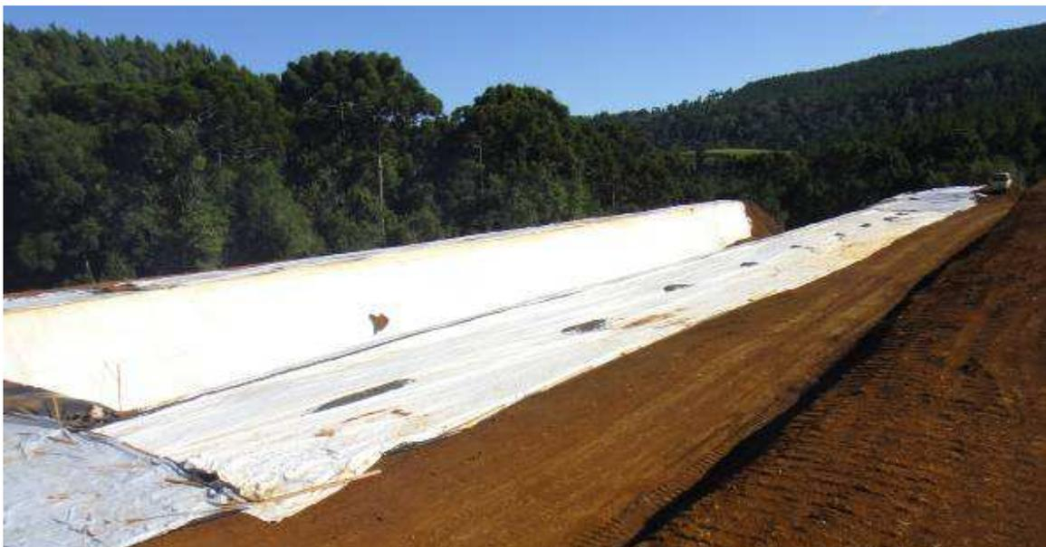
**Figura 37.** Exemplo de compactação dos taludes adjacentes à célula. **Fonte:** Cledson Wiezorek
