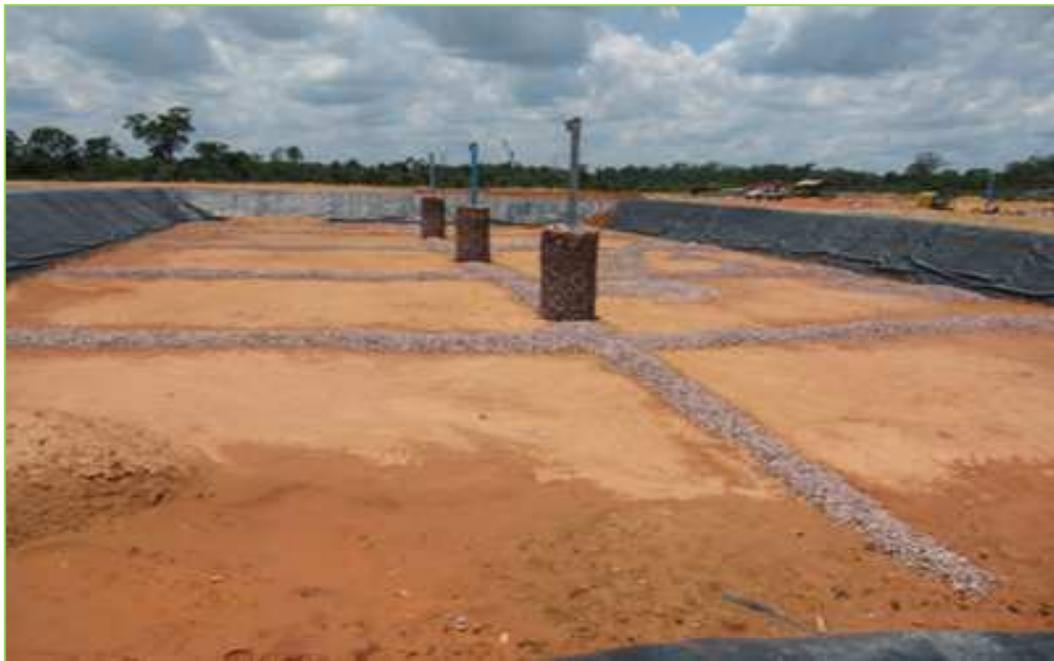
**Figura 45.** Exemplo de drenagem a ser instalada no fundo da célula. **Fonte:** <http://www.classirondonia.com.br>
