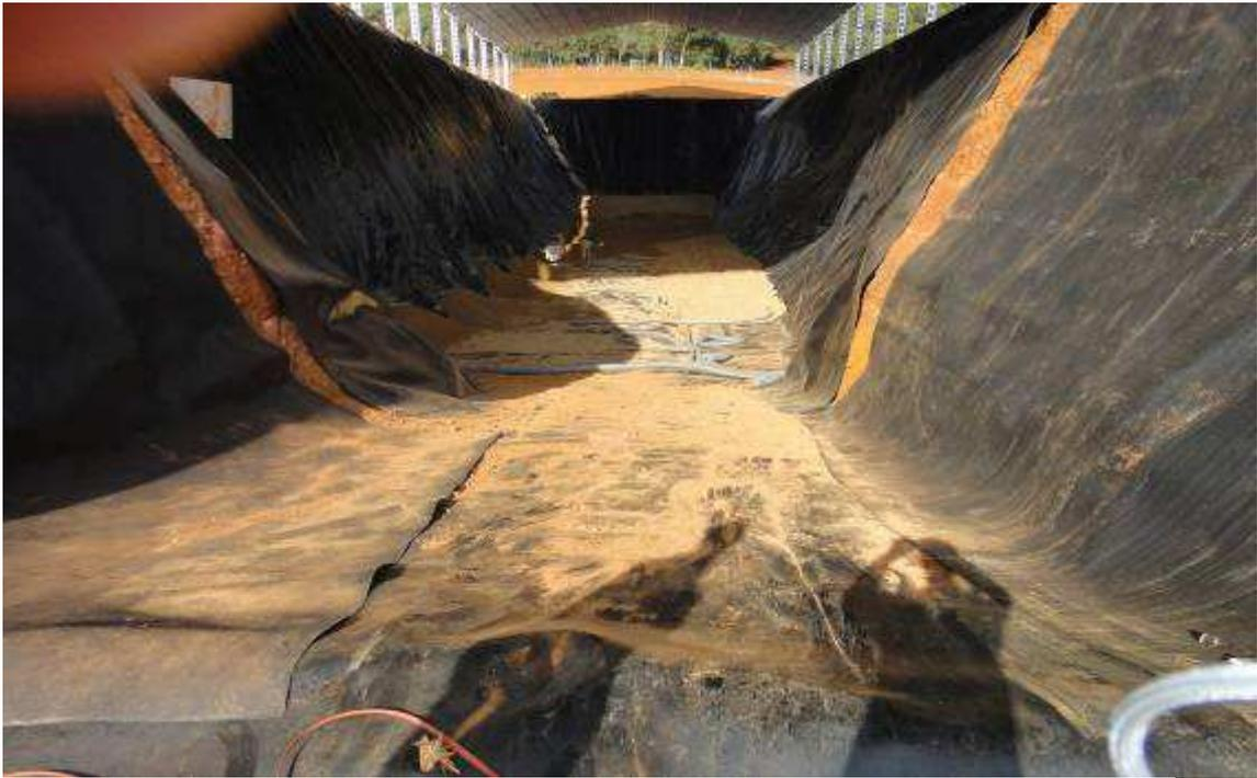
**Figura 42.** Aos fundos da imagem, observa-se a colocação de areia para cobrir os drenos. **Fonte:** Cledson Wiezorek
