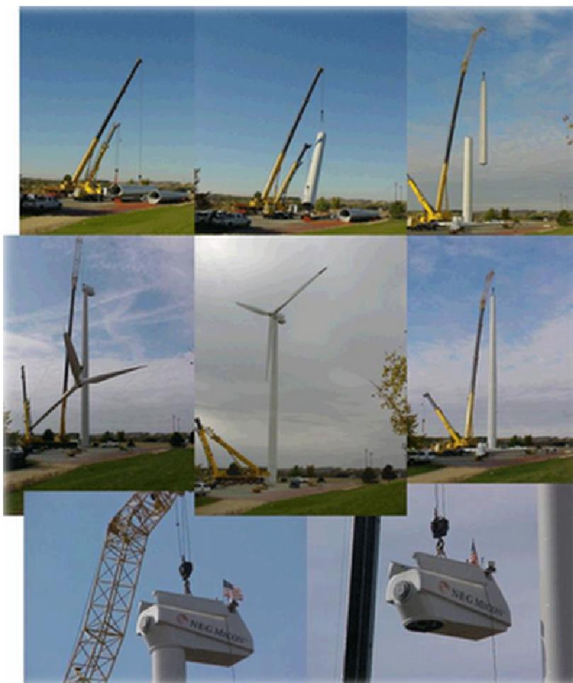
**Figura 3.7** - Seqüência de montagem do aerogerador, da colocação da estrutura ao rotor na nacele.
