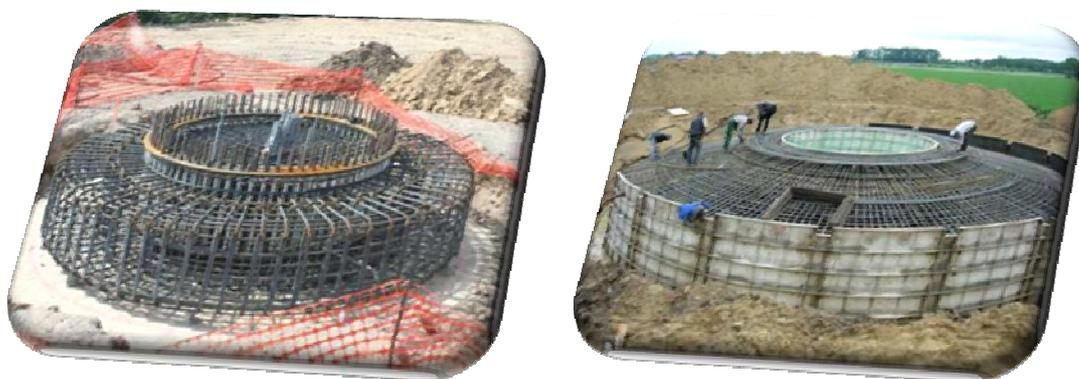
**Figura 3.6** - Modelo de estrutura da base para alocação da torre de um aerogerador.
