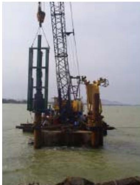
**Figura 2.23 – Cravação de estacas metálicas com a utilização de guindaste montado sobre balsa e martelo diesel**
