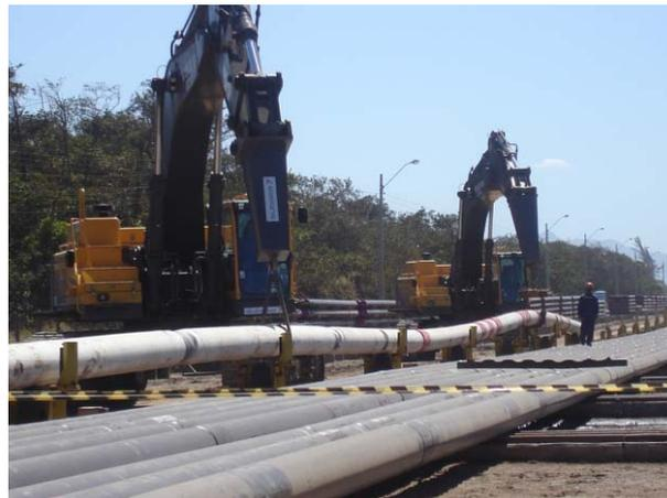
Figura 2.20 – Vista dos “*Stalk racks*” na base em operação no ES
