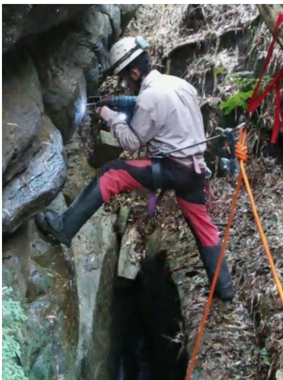
Foto 22: Detalhe da atividade para ancoragem para descida.
