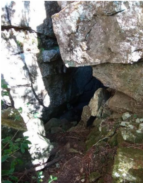
Foto 70: Vista geral da área com grandes blocos caídos.
