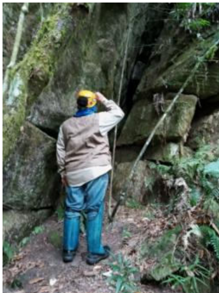
Foto 13: Fenda encontrada no ponto 152 do caminhamento no circuito 1
