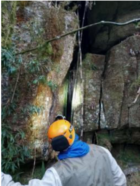
Foto 12: Fenda encontrada no ponto 150 do caminhamento no circuito 1
