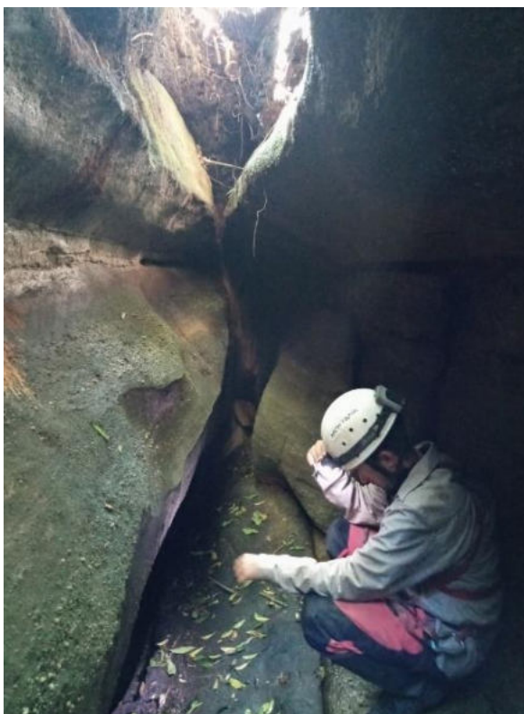
Foto 18: Detalhe dos blocos caídos no fundo do abismo e a água corrente.
