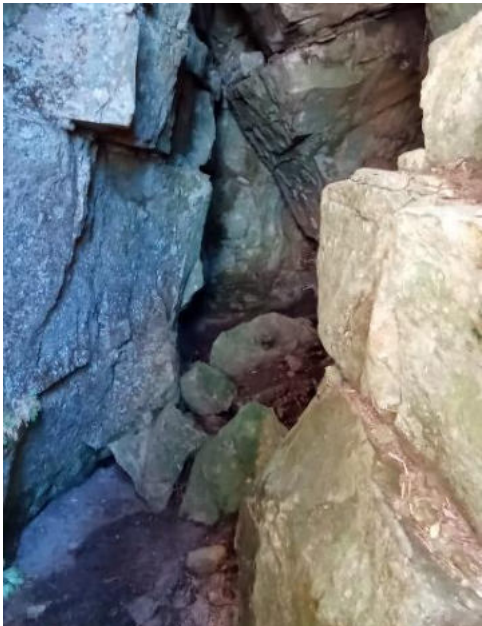
Foto 71: Vista geral dos blocos caídos.
