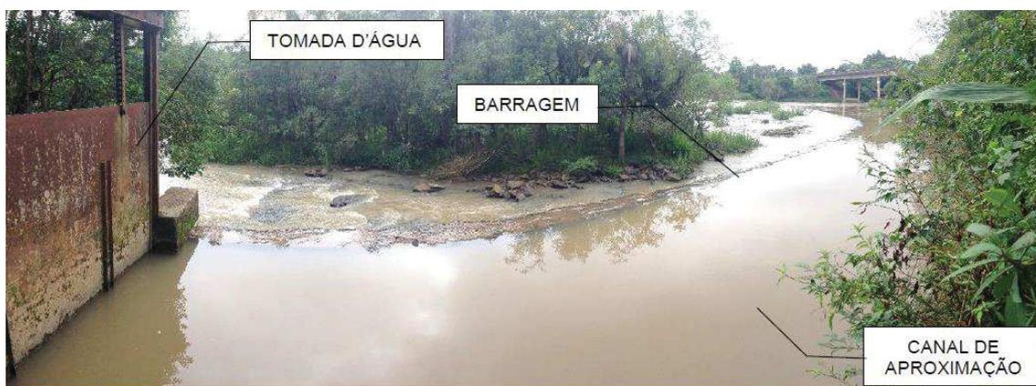
**Figura 2.1: Trecho da captação, canal de aproximação, tomada d'água e barragem.**
