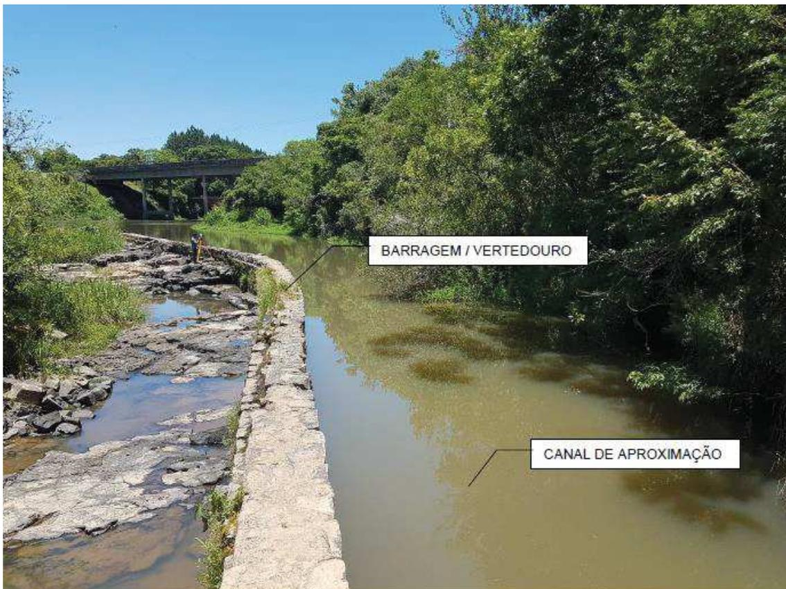
**Figura 2.2: Barragem/vertedouro e canal de aproximação.**
