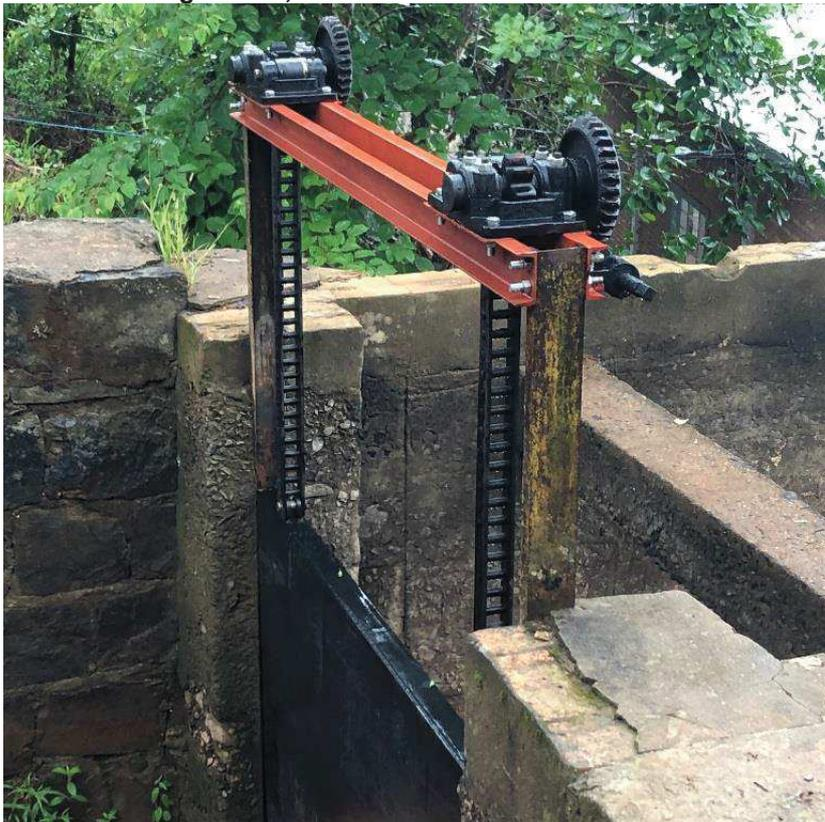
**Figura 2.8: Comporta e acionamento recuperados mediante reforma em fábrica especializada.**
