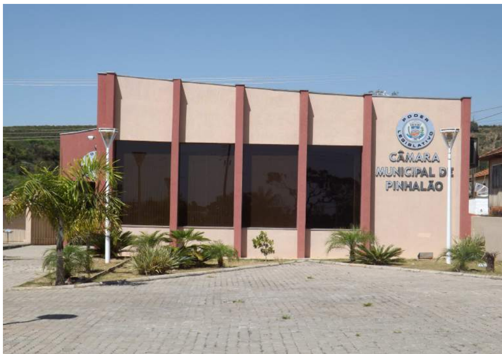
Figura 89: Câmara Municipal de Pinhalão. Fonte: Aecogeo, 2013.
