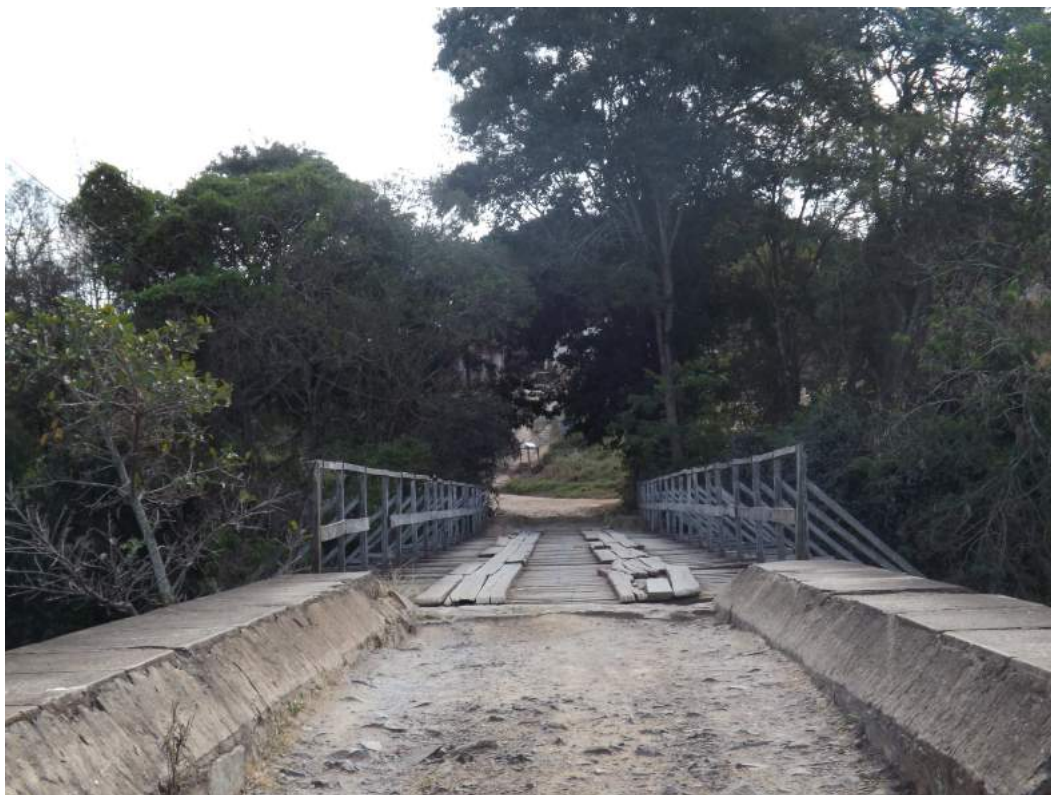
Figura 114: Vista superior da Ponte de Ferro. Fonte: Aecogeo, 2013.
