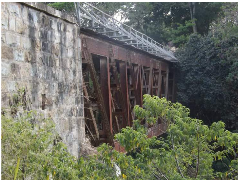
Figura 113: Ponte de Ferro. Fonte: Aecogeo, 2013.
