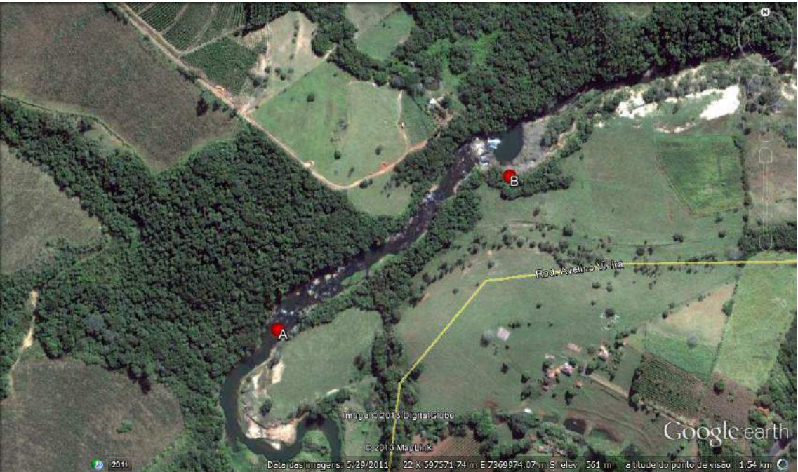
Figura 42: Área do entorno da área de amostragem, sendo (A) o barramento e (B) a casa de força. Pinhalão / PR. Fonte: modificado do Google Earth, 2013. Fonte: Google Earth, 2013.
