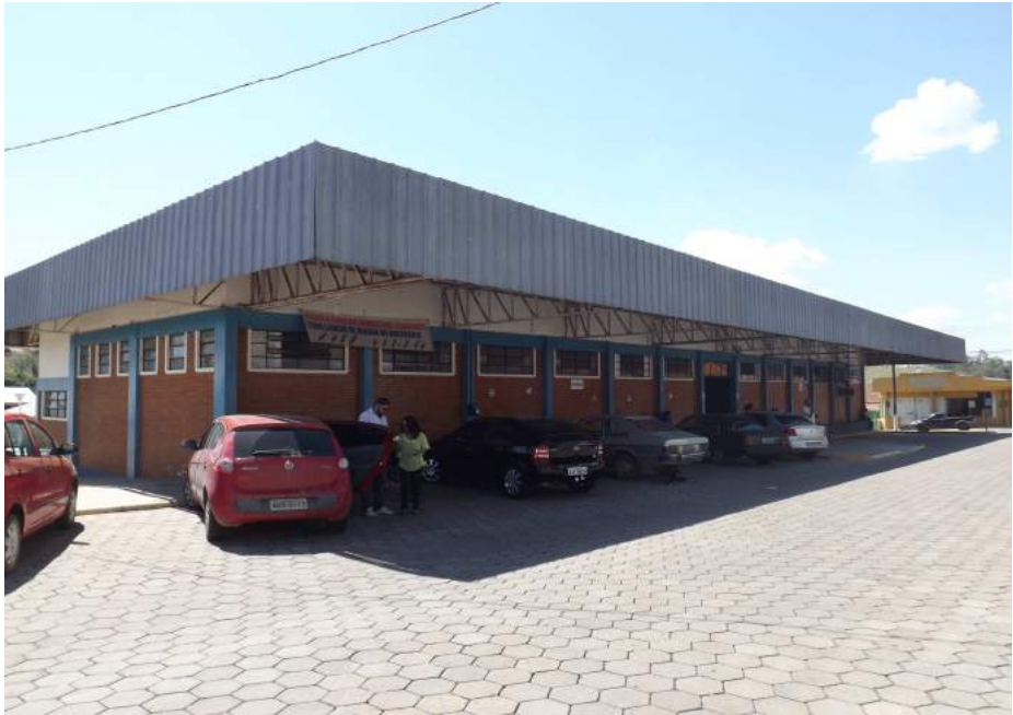
Figura 108: Terminal Rodoviário de Pinhalão. Fonte; Aecogeo, 2013.
