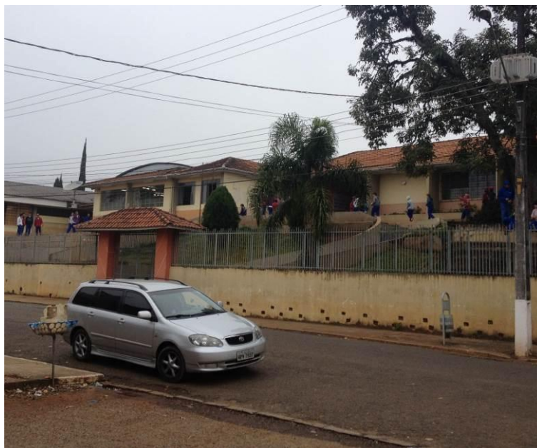
Figura 119: Escola de General Carneiro.
