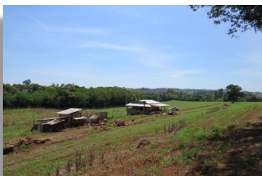
Estrutura iniciada para instalação de viveiro para produção de bicho-da-seda
