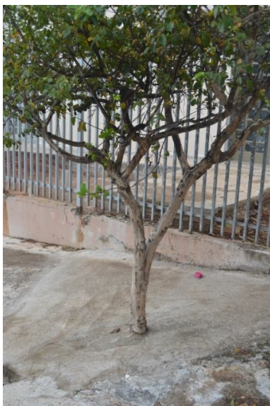
Figura 1 - Afogamento de raiz com concreto
