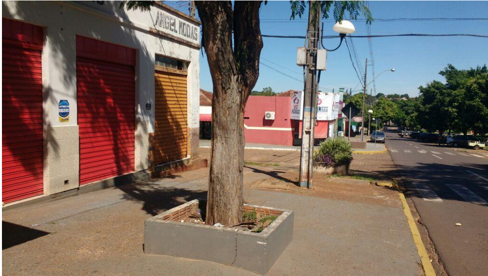
Figura 9 – Muretas impedindo a infiltração de água
