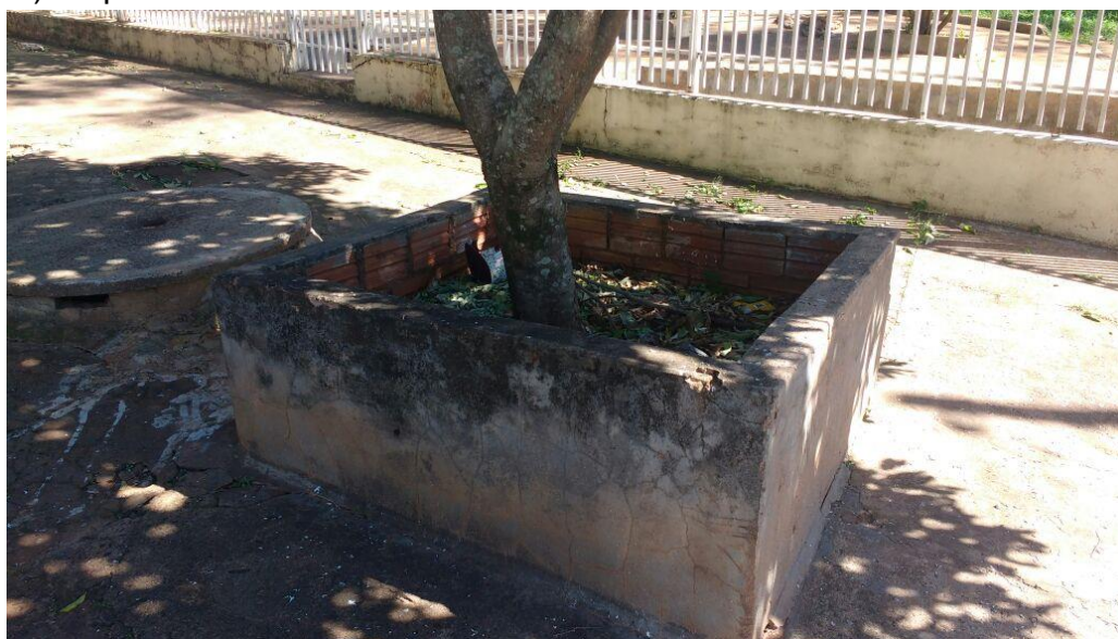
Figura 8 – Muretas impedindo a infiltração de água
