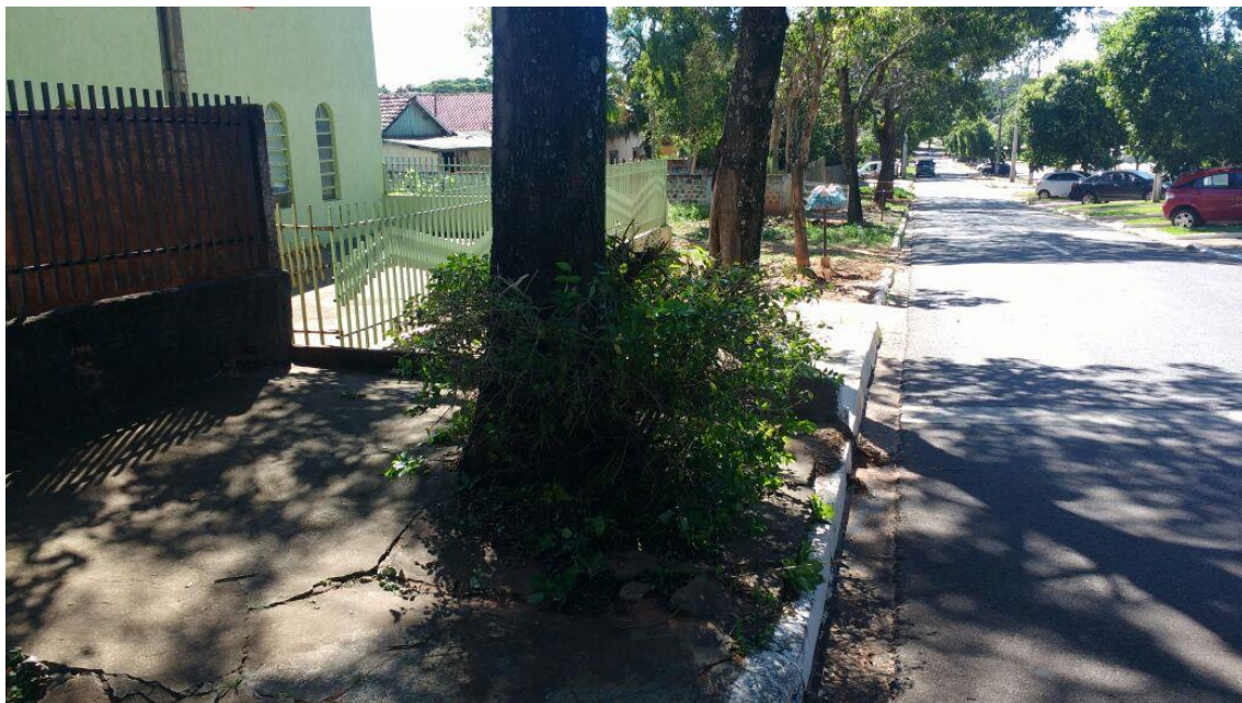
Destruindo calçada, junto ao meio fio
