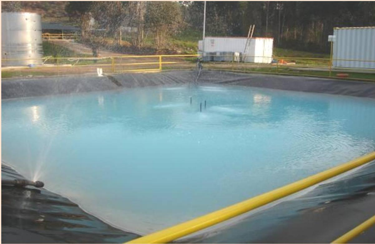
FIGURA 41 - TANQUE DE ARMAZENAMENTO DE LIQUIDOS PERCOLADOS TRATADOS
