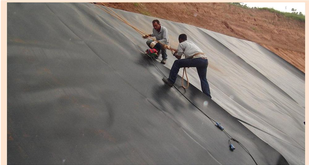
FIGURA 27 – INSTALAÇÃO DA GEOMEMBRANA
