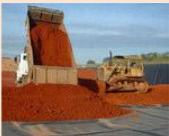
FIGURA 24 – GEOMEMBRANA (DESCARREGAMENTO DE SOLO)
