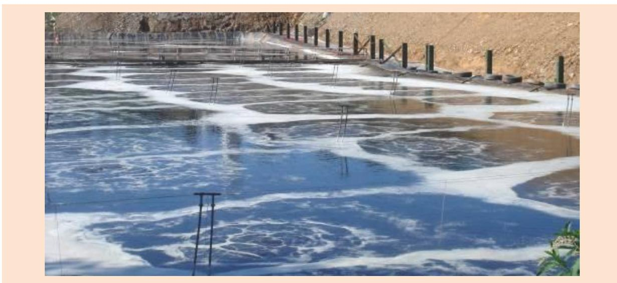
FIGURA 39 - VISTA DE UMA LAGOA AERADA E IMPERMEABILIZADA
