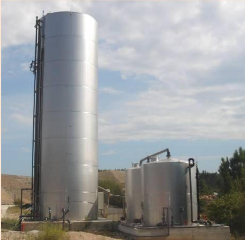
FIGURA 40 – PLANTA DE FLOTAÇÃO E HOMOGENEIZAÇÃO
