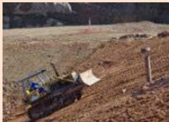
FIGURA 17 – COBERTURA DA CÉLULA DE DISPOSIÇÃO COM CAMADA DE SOLO.
