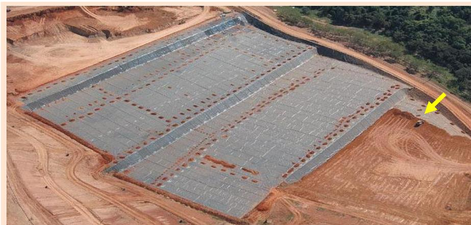
FIGURA 28 – ÁREA IMPERMEABILIZADA COM GEOMEMBRANA
