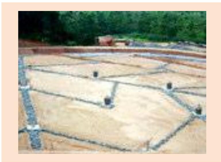
**FIGURA 34 – SISTEMA DE DRENAGEM DE LÍQUIDOS PERCOLADOS**
