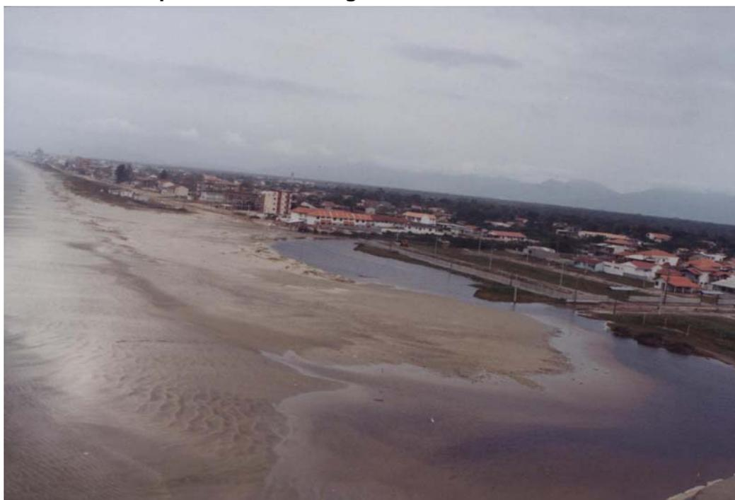
**Figura 3.30. Embocadura do Rio Matinhos Assoreada pelos Sedimentos, Causando Diminuição na Capacidade de Drenagem.**
