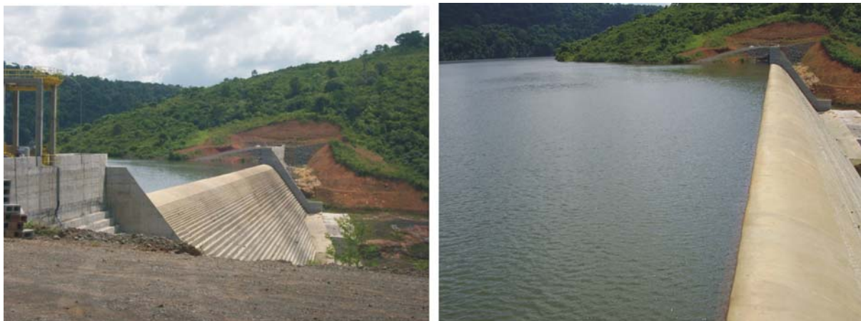
FIGURA 23 – RESERVATÓRIO DA USINA FUNDÃO
