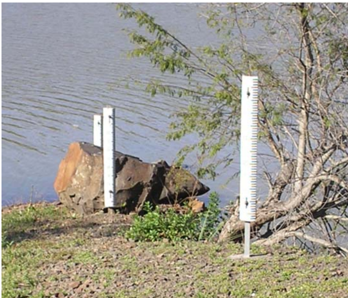
FOTO 14 – RÉGUA INSTALADA A JUSANTE DO DESVIO DO RIO JORDÃO DA UHE SEGREDO
