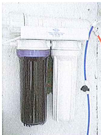
Figura 6: Filtro Osmose Reversa
