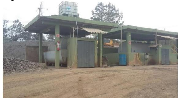
Figura 2.11: Tanque aéreo de combustível.
