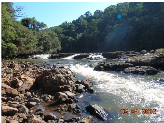
Figura 7: Pequena cachoeira no rio Chagu localizada em torno de 1km abaixo do futuro barramento. Podemos observar os blocos rolados e o substrato rochoso que compõem o rio. Fonte: ECOSSIS, 2016.
