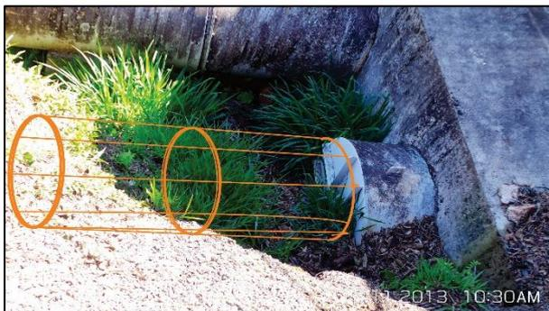
Figura 6 – Detalhe da espera onde será acoplado o novo conduto forçado (croqui).
