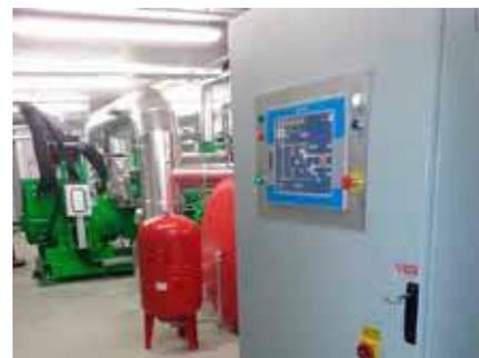
**Morgex** (Aosta, Itália) - recuperação de calor a partir de jaquetas de refrigeração e escapamentos dos motores a óleo vegetal
