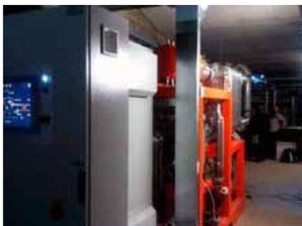
**Roma** (Itália) - Recuperação de calor a partir de jaquetas de refrigeração e escapamentos dos gaseificadores e motores a syngas
