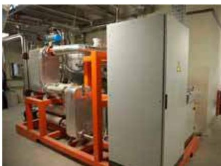
**Meran** (Bolzano, Itália) - Recuperação de calor a partir de jaquetas de refrigeração e escapamentos dos gaseificadores e motores a syngas
