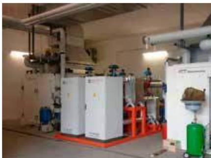
**Renon** (Bolzano, Itália) - recuperação de calor a partir de jaquetas de refrigeração e escapamentos dos motores a óleo vegetal
