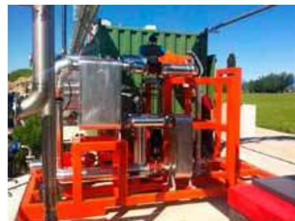
**S. Pietro in Gu** (Padova, Itália) - Recuperação de calor a partir de jaquetas de refrigeração e escapamentos dos motores a biogás
