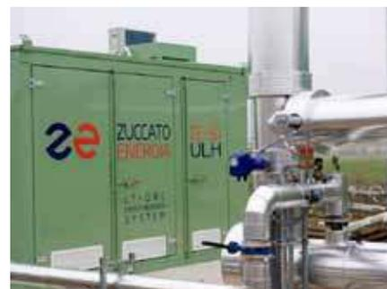
**Borgoforte** (Mantova, Itália) - Recuperação de calor a partir de jaquetas de refrigeração e escapamentos dos motores a biogás
