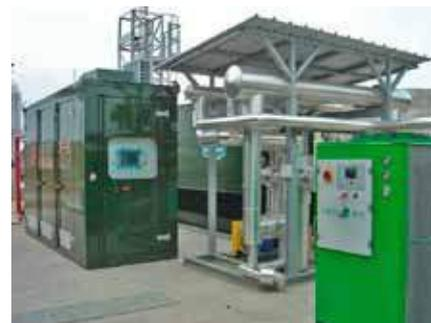
**Portogruaro** (Veneza, Itália) - Recuperação de calor a partir de jaquetas de refrigeração e escapamentos dos motores a biogás
