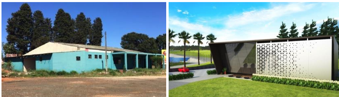
Figura 18: Edificação abandonada à esquerda e Imagem da fachada da central de controle (direita)
