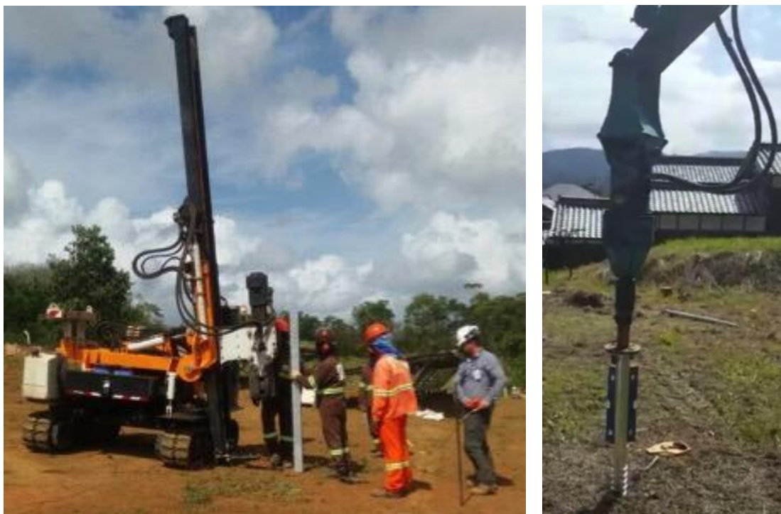
Figura 14: Exemplo de estaqueamento à esquerda e exemplo de fundação com parafusos de solo à direita
