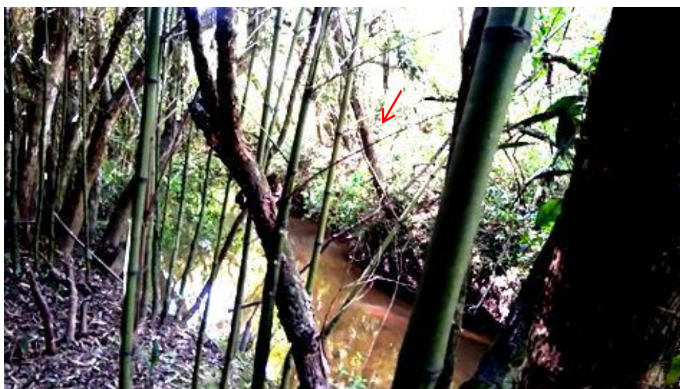
Figura 50: Visualização da margem direita do Rio Capivara. Tronco bastante inclinado demonstrando a movimentação do solo na margem
