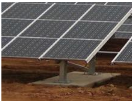
Figura 15: Fundação em concreto
