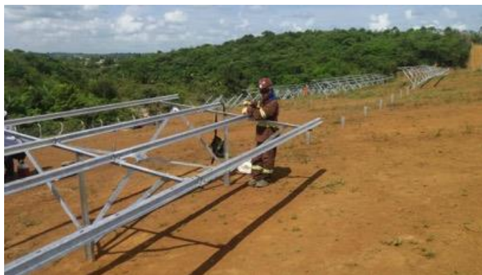
Figura 16: Montagem de mesas fotovoltaicas
