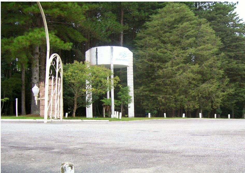
Portal de Entrada
