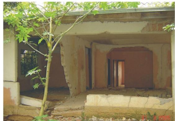
FOTOGRAFIAS 4 e 5 - Colapso induzido pela extração de água subterrânea
