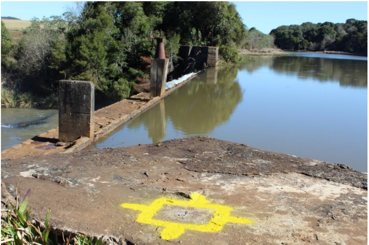
Figura 5: vista do reservatório e barramento
