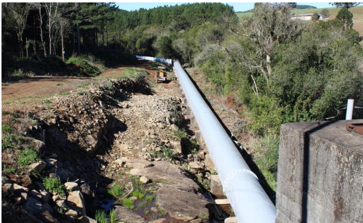
Figura 4: Conduto instalado sobre o antigo canal de adução
