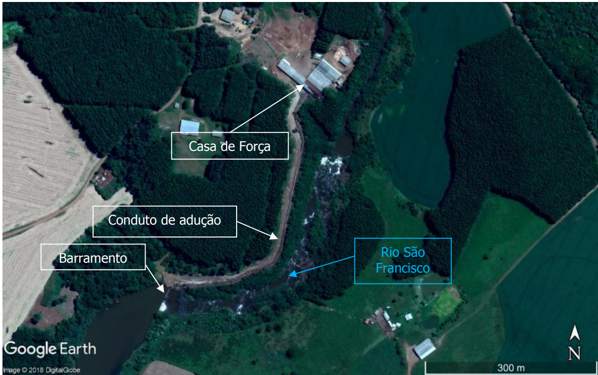
Figura 1 - Estruturas existentes da CGH ARFIMAC
