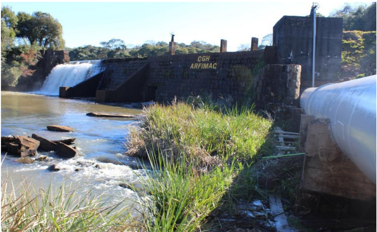
Figura 13: Barramento, vertedouro e conduto de adução
