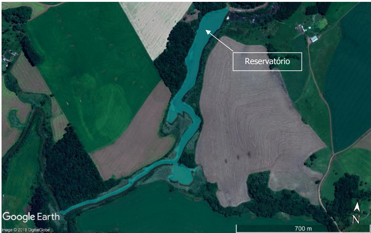
Figura 2: Reservatório existente da CGH ARFIMAC
