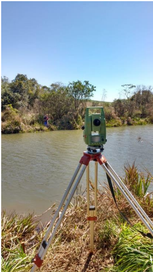
Figura 24: Estação Total na demarcação da cota do Reservatório
