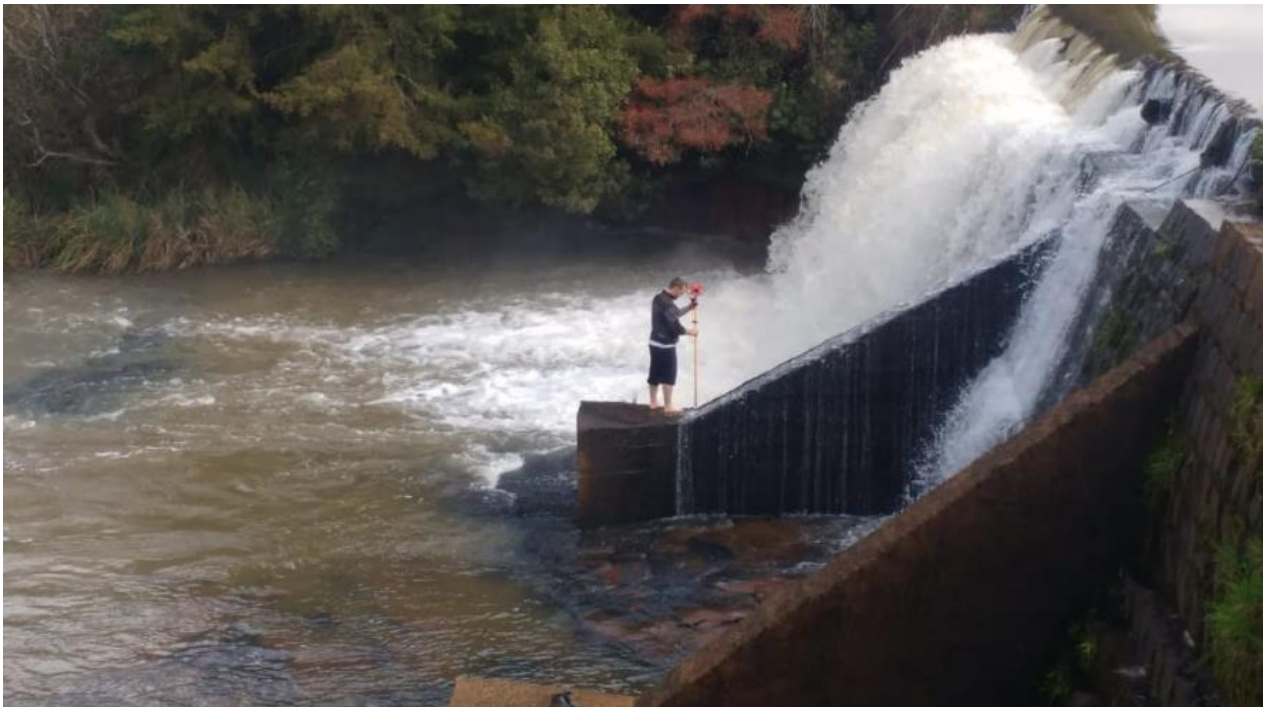
Figura 23: Levantamento trigonométrico na estrutura da barragem
