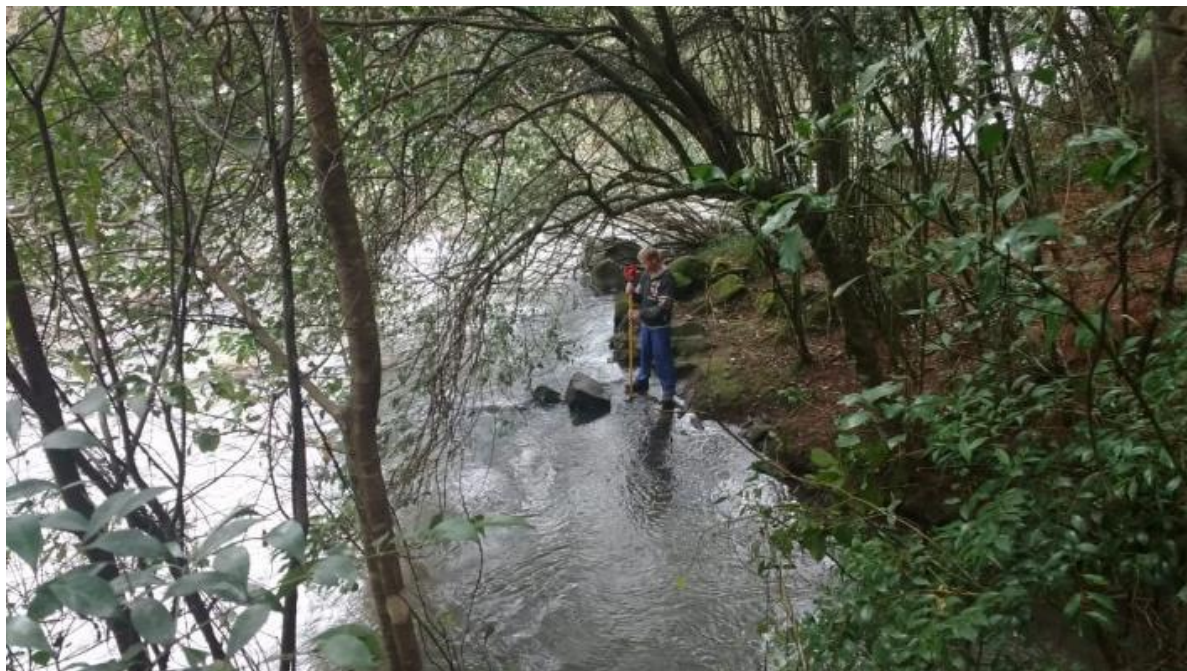
Figura 20: Canal de Fuga
