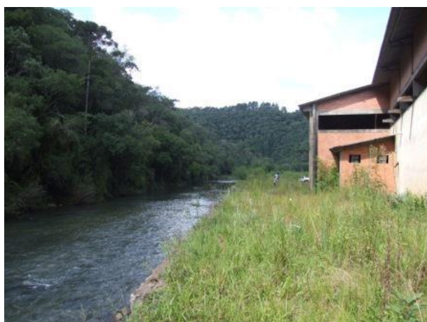
Figura 65 : Contraste da vegetação entre as margens do rio da Estrela próximo a casa de força da usina desativada
