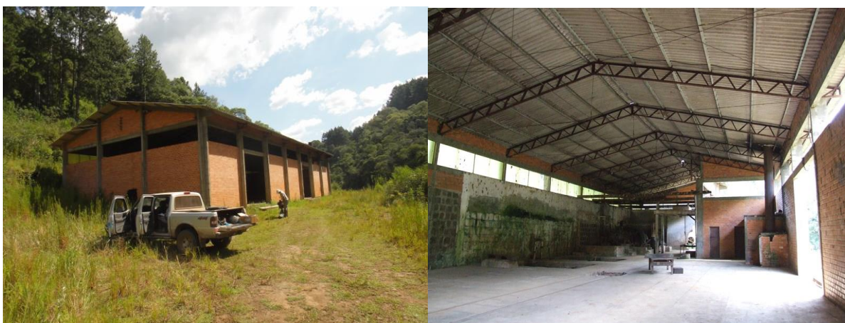
Figura 90: Antiga fábrica de celulose e casa de força da usina às margens do rio da Estrela
