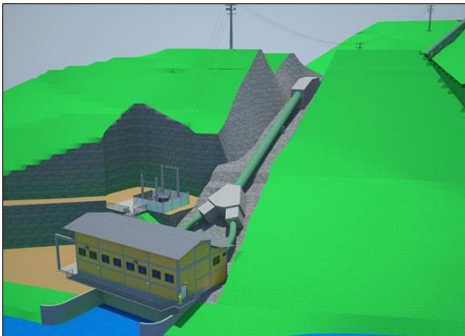
**Figura 4.11: Representação do conduto forçado e casa de força.**
