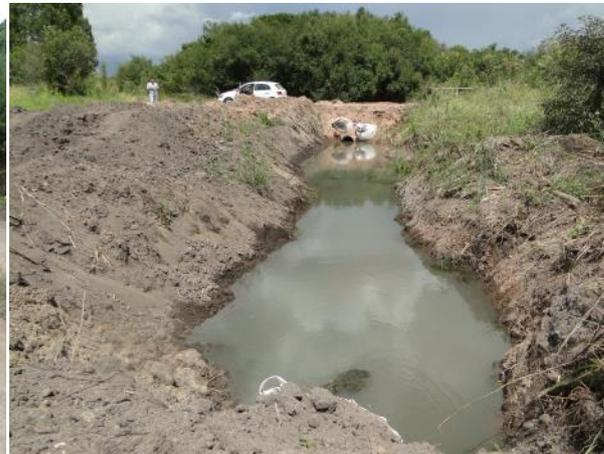
Arroio Inhoaíva – Modificado e Canalizado para drenagem das áreas agricultáveis – Estaca 6 + 400
