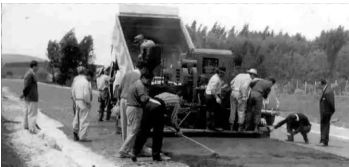
Figura 48 – Pavimentação da Rodovia do Café. Foto: DER
