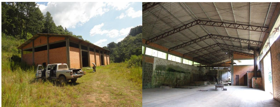
Figura 88: Antiga fábrica de celulose e casa de força da usina às margens do rio da Estrela
