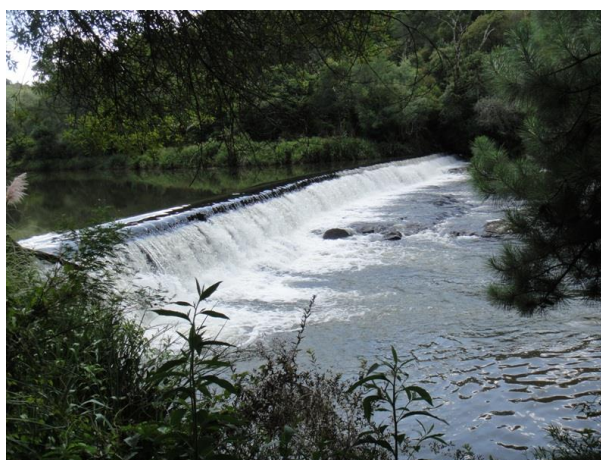
Figura 6: Barramento da usina hidrelétrica desativada no rio da Estrela
