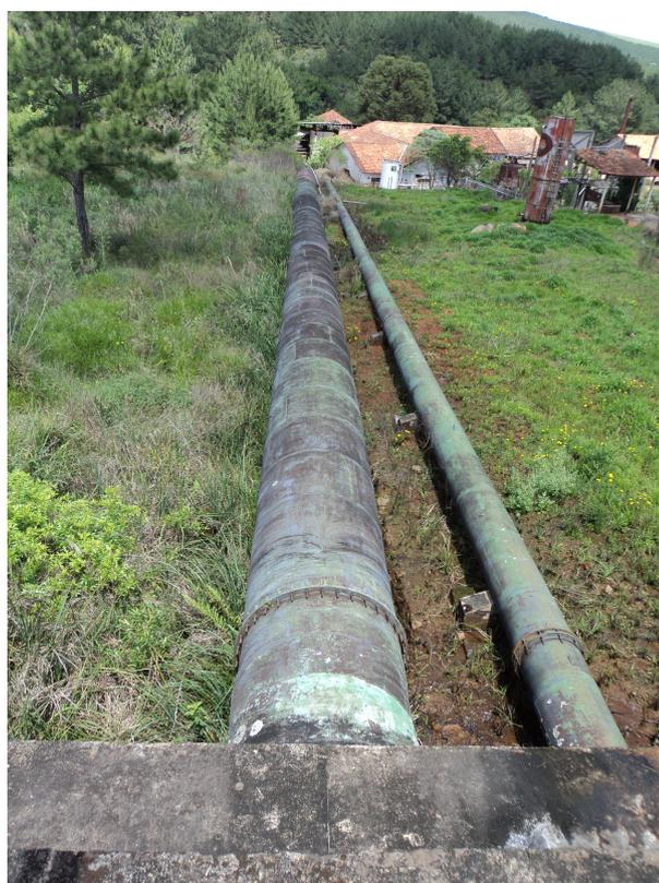
Figura A.5: Tubulação que leva a água às turbinas. Fonte: CATAFLOR, 2010.
