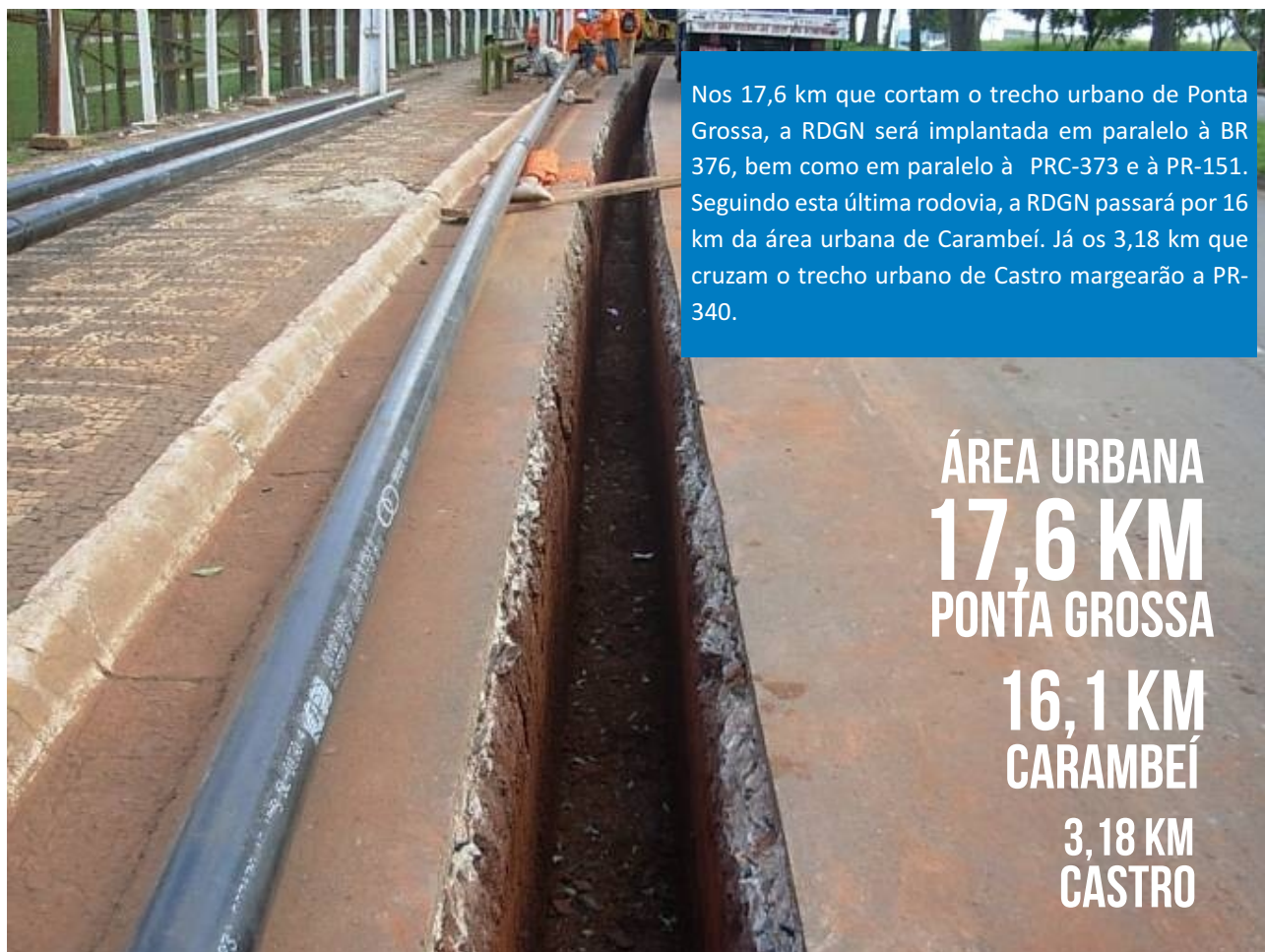
EXEMPLO DE VALA ABERTA EM VIA PÚBLICA PARA INSTALAÇÃO DA REDE
