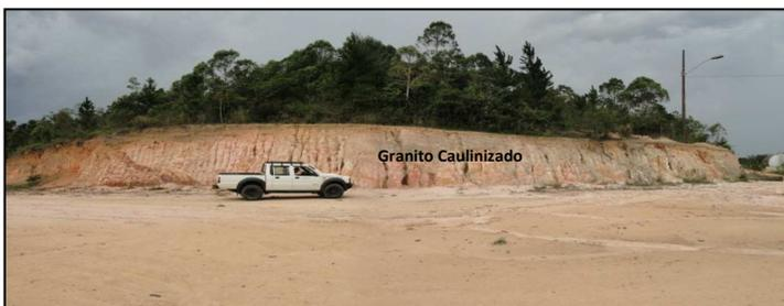
Área decapada e aplainada para utilização como pátio de estocagem/ estacionamento em projeto de reflorestamento; atentar para o talude e piso escavados em granito completamente intemperizado/caulnizado.
