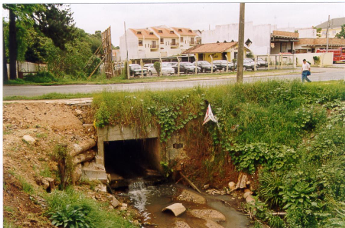
**F10.17.** Trecho de travessia do rio Uvú na Av. Vereador Toaldo Túlio, onde ocorrem processos de erosão e solapamento dos taludes marginais. Mancha de inundação CRT-122. Cenários de risco III e IV.
