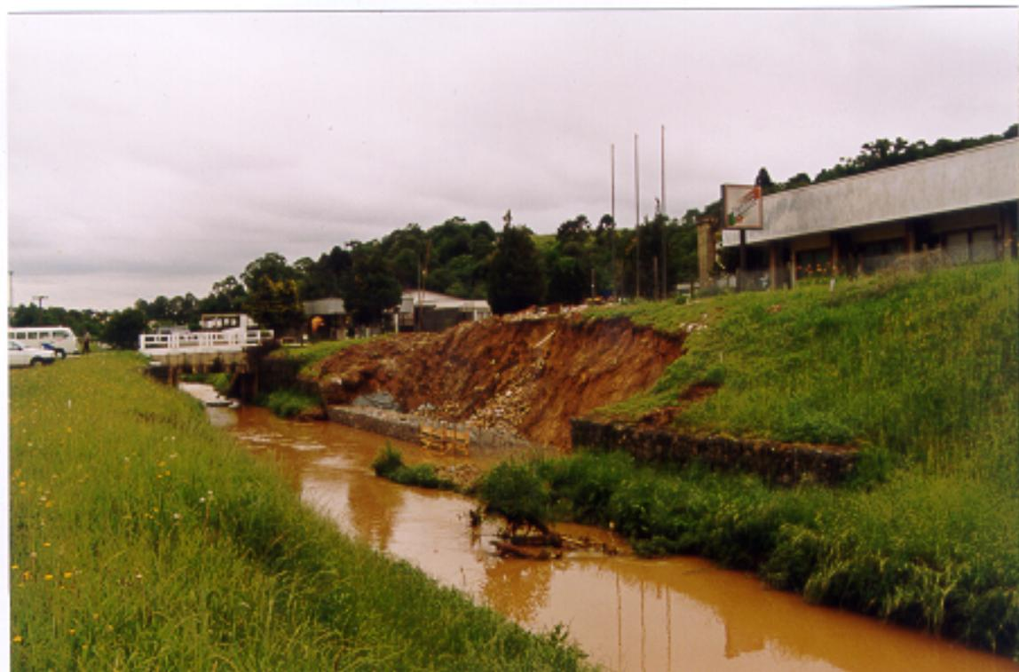
F1.1. Erosão e solapamento de talude marginal em razão do estrangulamento da seção do canal provocado pela ponte sobre o rio Barigui, no trecho em frente à fábrica da Brahma. Mancha de inundação ALT – 1. Cenários de risco III e V.
