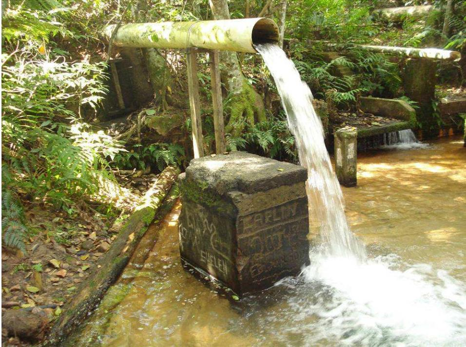
Figura 12 – Pilar de concreto recoberto por musgos e degradado por ações de vandalismos.
