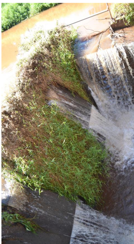
Figura 04. 50 metros após o TVR, a barreira física construída no rio São Francisco ponto 9, lat. 24°46'35.59"S e long. 53°43'24.66"O.
