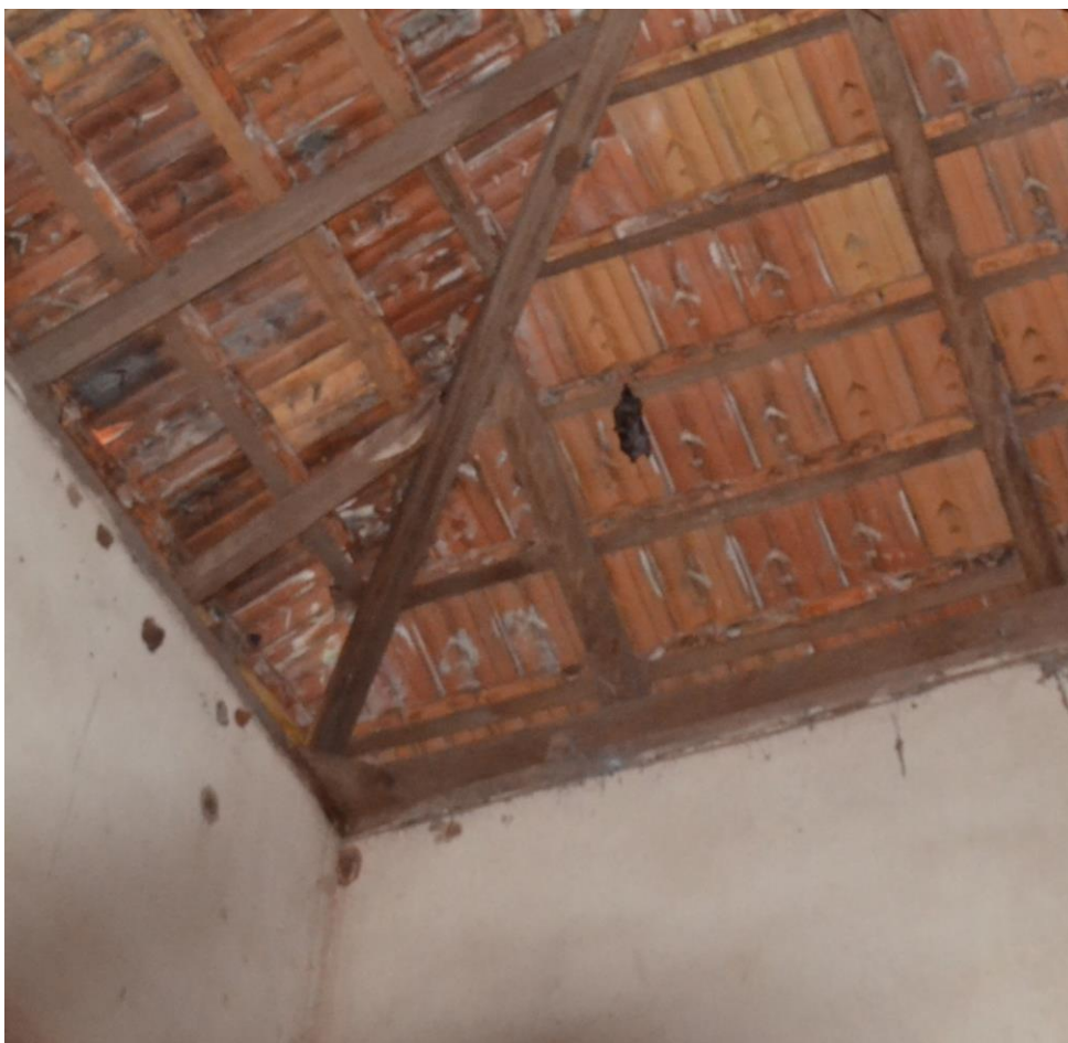
Figura 14. Registro fotográfico de morcegos, dentro da antiga casa de máquina da Usina Carlos Becker que inundou na década de 70/80, ponto 15. lat. 24°46'38.14"S e long. 53°43'56.32"O, largura de 6m do rio.
