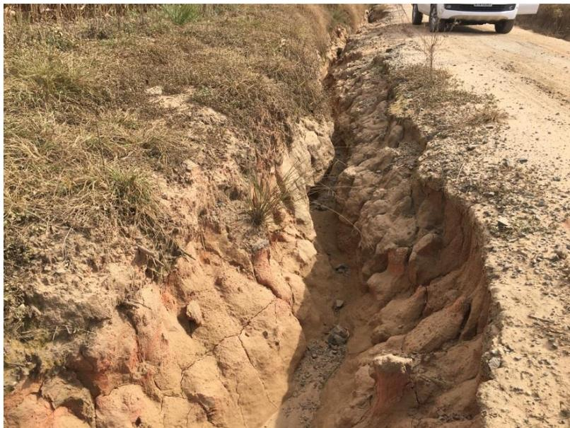
Figura 198: Erosão pluvial verificada ao longo de uma via de acesso inserida na AID, próximo ao vértice V3 (C1).
