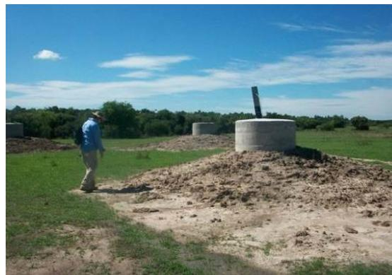
Figura 22: Fundação tipo tubulão finalizada.
