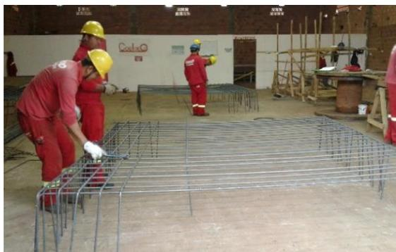
Figura 24: Vista de confecção de ferragens de fundação tipo sapata em canteiro de obras.
