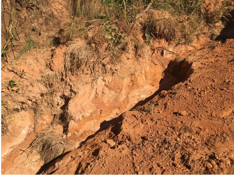
Figura 200: Focos de erosão em solos do tipo Argissolos Vermelho-Amarelos, identificado próximo ao vértice V12 (C1).
