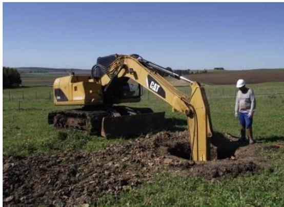
Figura 19: Exemplo de escavação do tipo tubulão.
