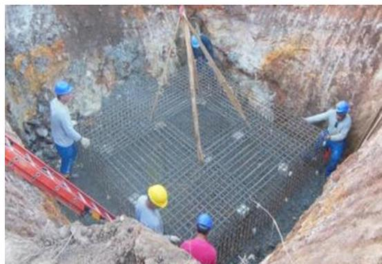
Figura 27: Exemplo de preparação de fundação do tipo sapata.
