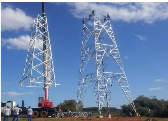
Figura 43: Vista de atividade de montagem de estrutura autoportante.
