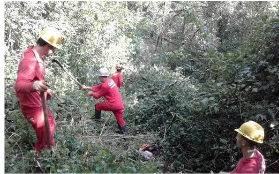
Figura 11: Abertura de trilha para supressão de eixo central de LT.
