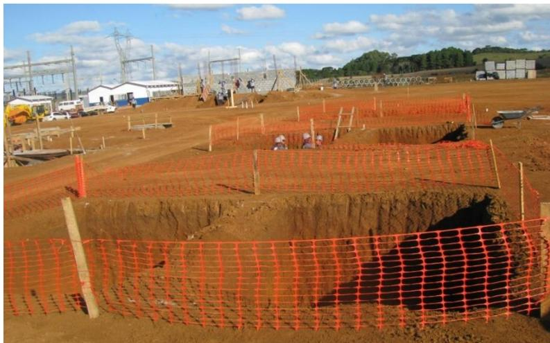
Figura 57: Exemplo de atividades iniciais de escavação para fundações e locação de estruturas.
