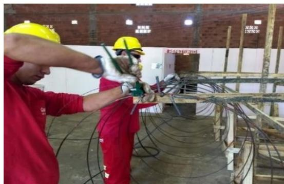
Figura 25: Vista de confecção de ferragens de fundação tipo tubulão.
