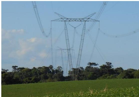
Figura 47: Exemplo de Torre do tipo estaiada já concluída, em empreendimento similar em operação.
