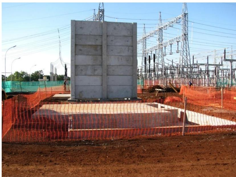
Figura 58: Exemplo de Subestações já instaladas, detalhando as paredes contra-fogo e bacia de contenção de óleo na base de transformadores.
