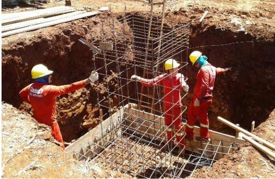
Figura 28: Vista de preparação para concretagem de fundação tipo sapata.
