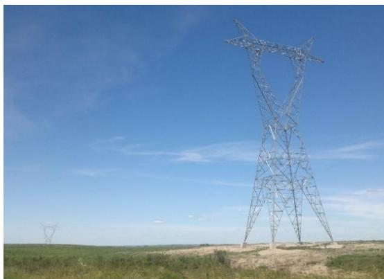
Figura 44: Torre concluída para a etapa de lançamento de cabos.
