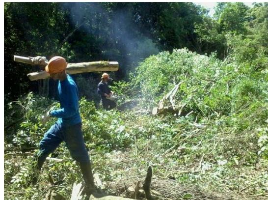
Figura 15: Equipe de supressão realizando o corte de vegetação e limpeza em praça de torre.
