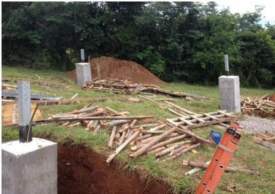
Figura 30: Fundação tipo sapata após concretagem e desforma.
