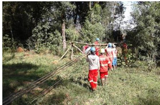
Figura 52: Vista de atividade de lançamento de cabos em travessia de cercas e de vegetação.
