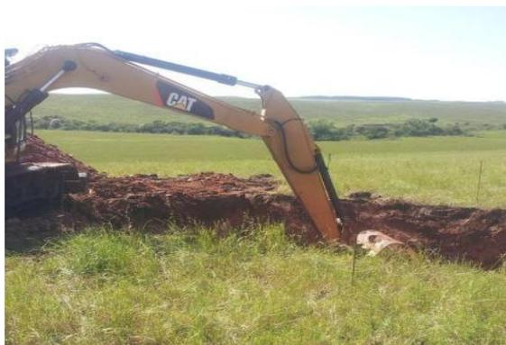
Figura 26: vista de atividade de escavação em fundação tipo sapata.
