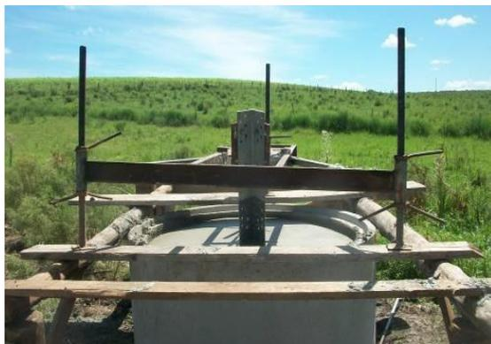
Figura 21: Detalhe de pé da torre do tipo tubulão após concretagem.
