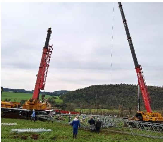
Figura 45: Pré montagem e montagem com auxílio de guindaste em torre estaiada.
