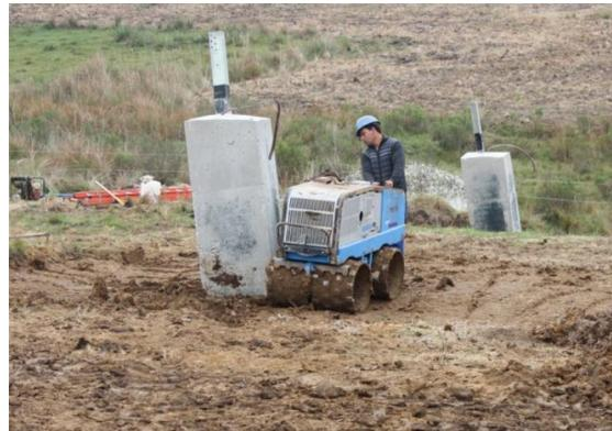
Figura 31: Trabalho de reaterro e compactação sendo finalizado.
