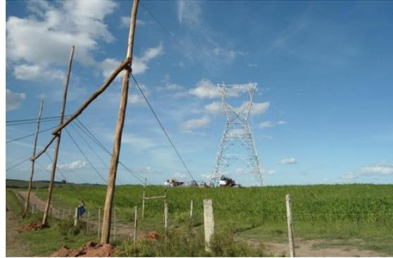
Figura 50: Empancadura junto à travessia de estrada rural.
