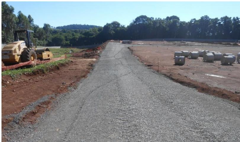
Figura 56: Vista de implantação de arruamento em subestação.
