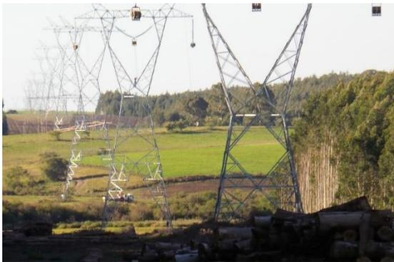
Figura 51: Torre “bandolada” pronta para lançamento de cabos.
