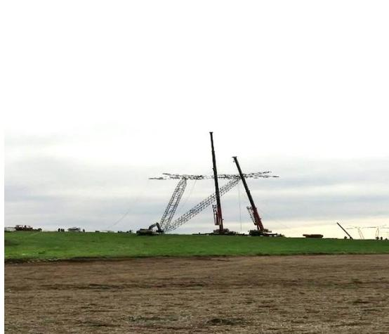
Figura 46: Içamento de estrutura tipo estaiada após a montagem em solo.
