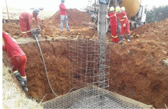
Figura 29: Vista de atividade de concretagem, para fundação tipo sapata.
