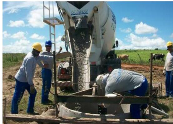
Figura 20: Atividade de concretagem em fundação tipo tubulão.
