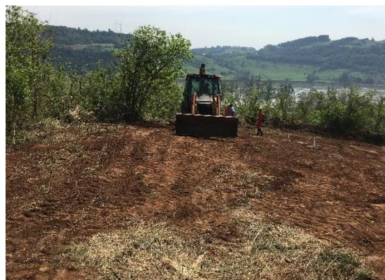
Figura 17: Limpeza de praça de torre com auxílio de retroescavadeira.
