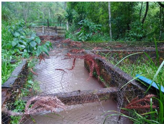
Figura 4 - Câmara de carga na CGH Pirâmide.
