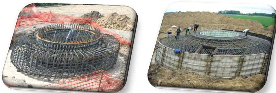
**Figura 3.6** - Modelo de estrutura da base para alocação da torre de um aerogerador.
