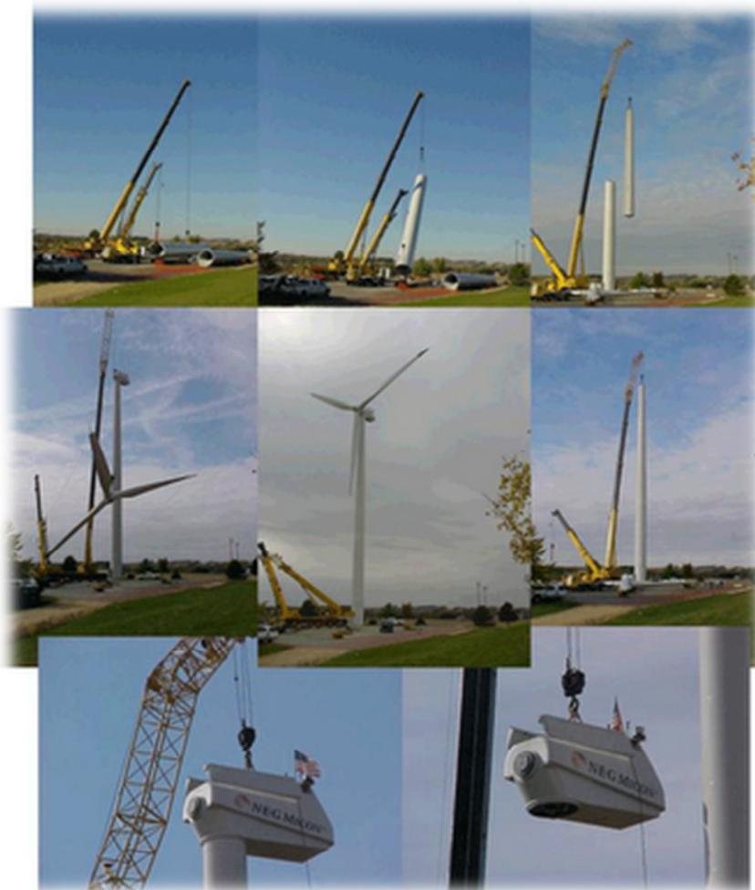
**Figura 3.7** - Seqüência de montagem do aerogerador, da colocação da estrutura ao rotor na nacelle.
