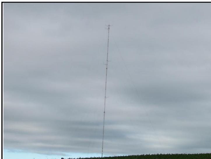
**Figura 3.1** - Torre anemométrica instalada na área do Parque Eólico Rosa dos Ventos – Marmeleiro/PR
