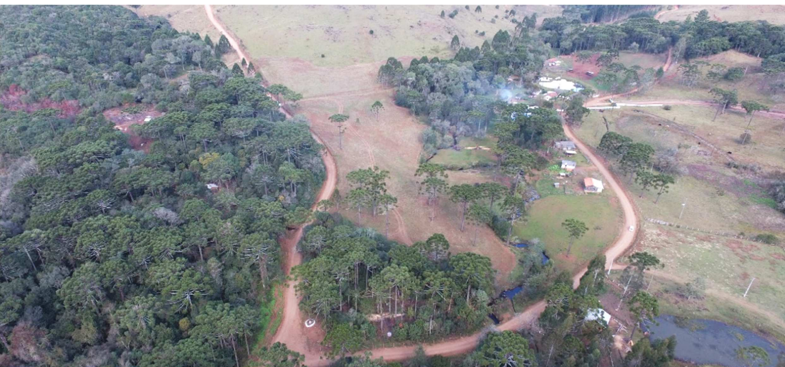
Estradas de acessos existentes
